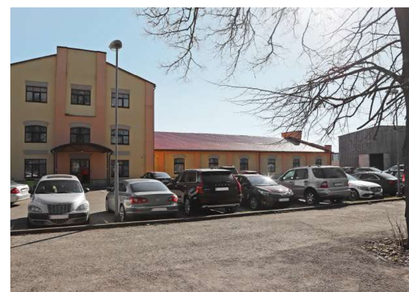
Vaade Viktoria restorani vastasküljel asuvale lammutatavale hoonestusele
