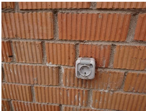
Fotod 4.10 ja 4.11 elektripaigaldise potentsiaalne oht trepikojas ja välisfassaadil 1,5 m kõrgusel
