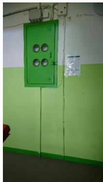
Fotod 4.7- 4.9 valik puuduva elektriohu märgiga elektrikilbidest korterelamute trepikodades
