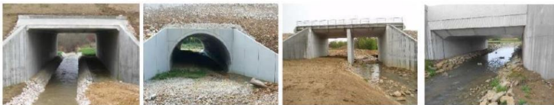
Joonis 1.2 Loomade läbipääsuks kohandatud truubid
