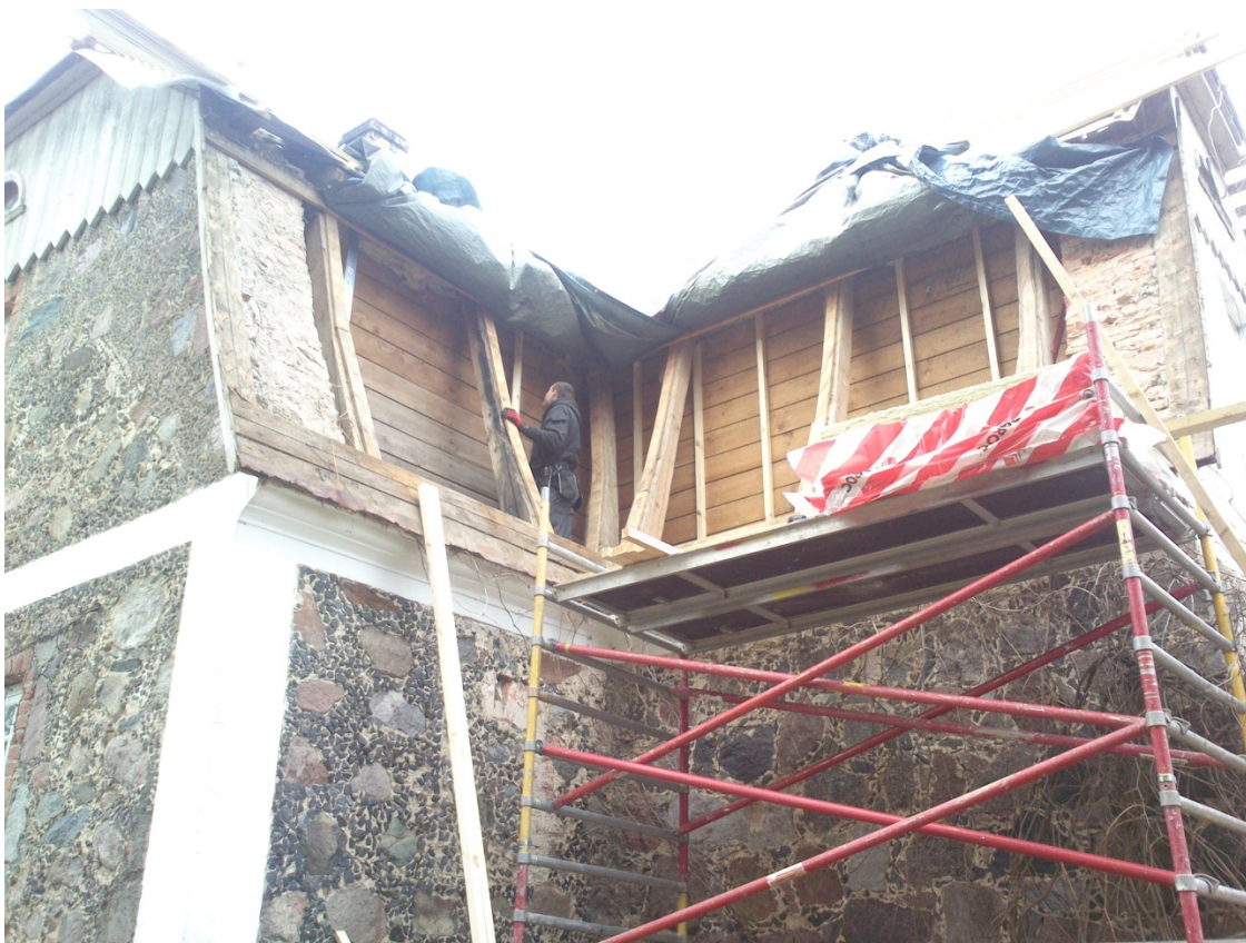
Joonis 3.5. Mansardkorrus. Pildil lisasoojustuskihi (kivivilla) paigaldamine roovituse vahele.
