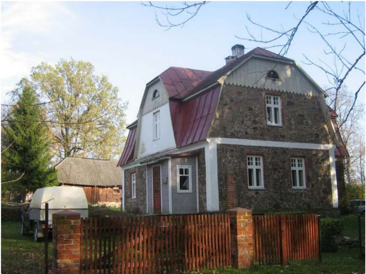
Joonis 3.1. Foto kärnerihoone idaküljelt.
