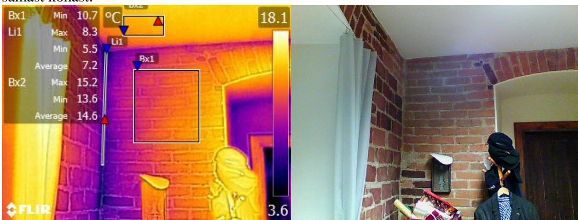
Joonis 4.4b. Külmasild välisseina liitekohas jaanuaris. Vasakul termopilt ja paremal foto samast kohast.
