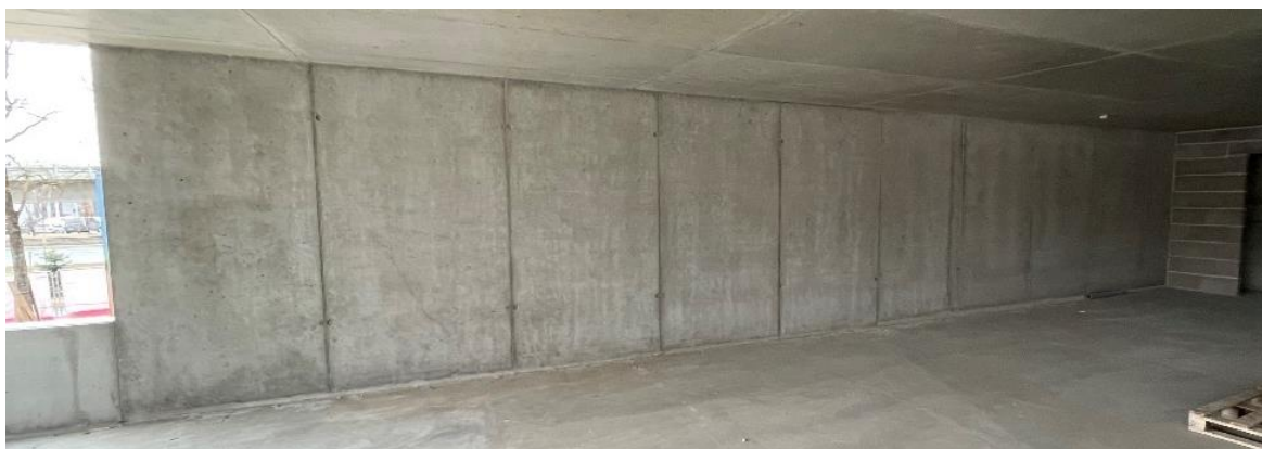
Foto 2.3.2.3 Objekt A, sein 2
