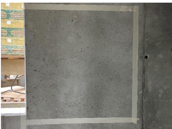
Foto 2.3.2.2 Objekt A, sein 1
