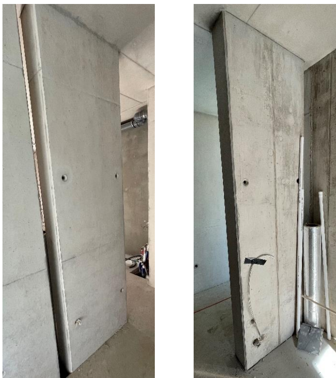
Foto 2.5.1.2 Objekt C, post 2
