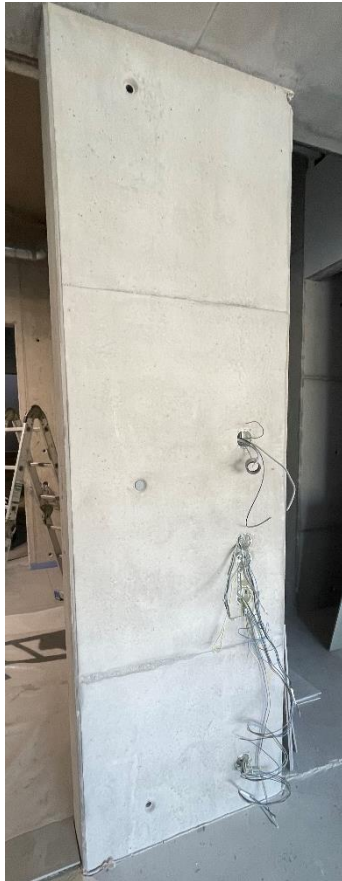
Foto 2.5.1.1 Objekt C, post 1
