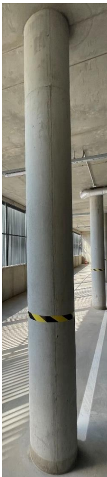
Foto 2.6.1.1 Objekt D, post 1
