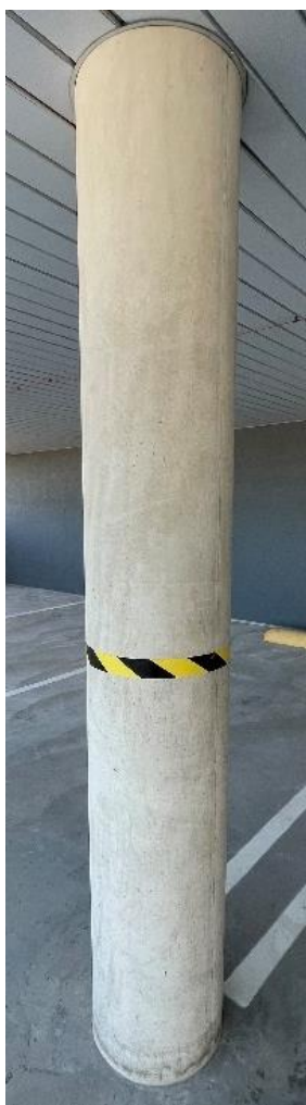
Foto 2.6.1.2 Objekt D, post 2
