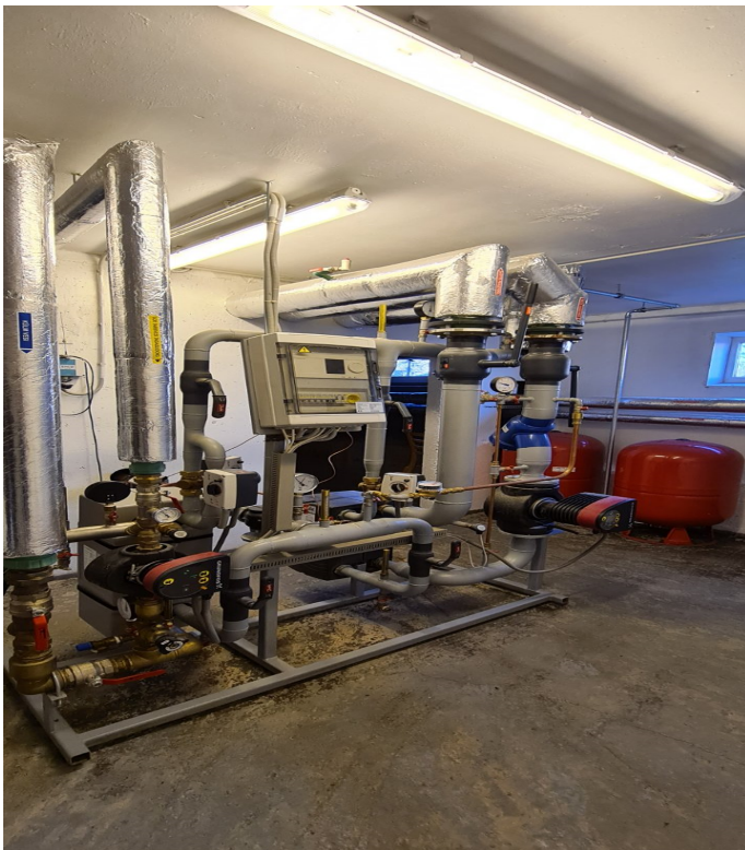
Joonis 2.8 Tüüpiline soojussõlm
