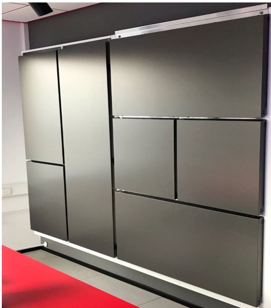
Joonis 5.3. Alumiiniumkomposiit kassetid näidisseinal Ruukki Pärnu fassaaditehases.
