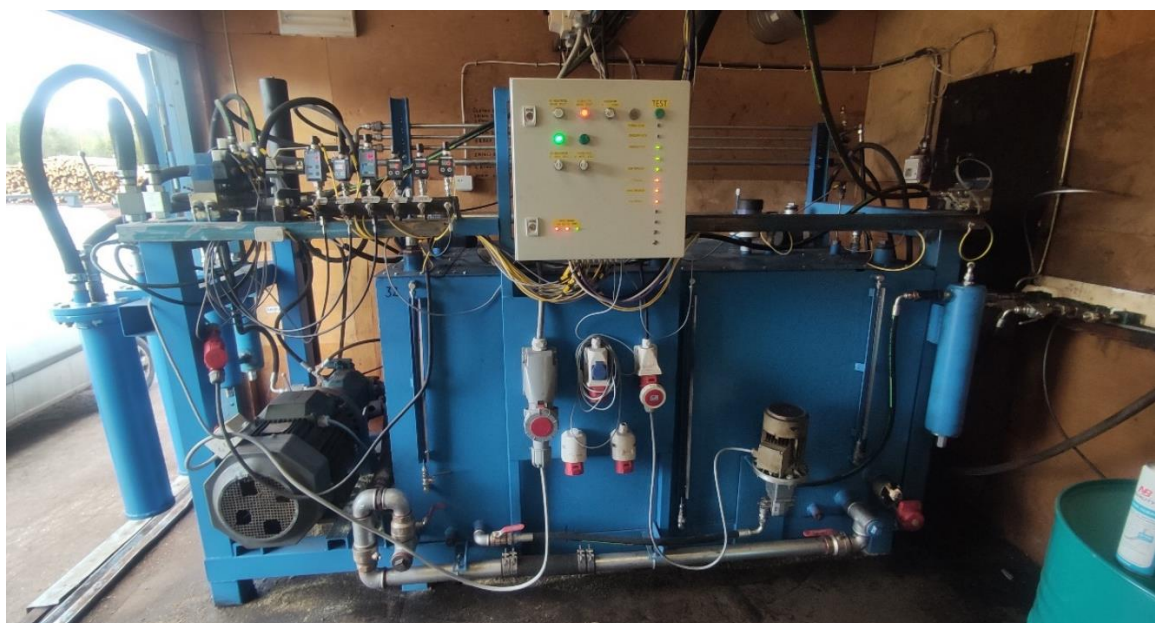
Joonis 4.16 Installeerimisjärgus uus hüdrokeskus
