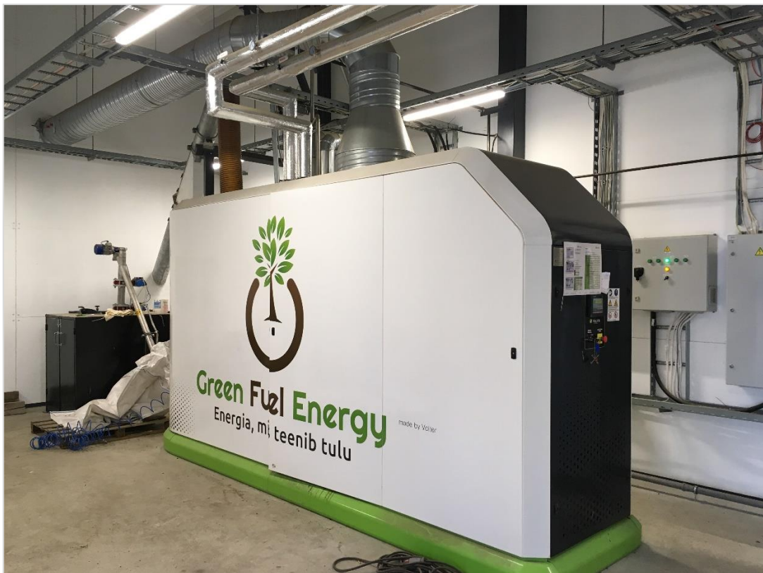
Joonis 3.1 Paigaldatud GFE45 koostootmiseseade Scanweld AS tootmisbaasis. Pildi autor: Henry Rebane
