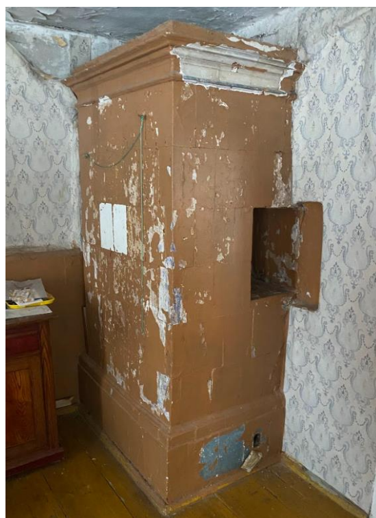
Joonis 3.40 Põhjapoolseid tubasid soojendav ahi (autori foto)
