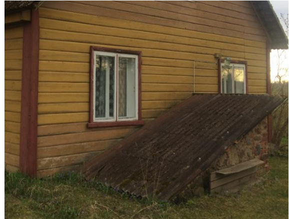
Joonis 3.8 Keldri eterniidist katus (autori foto)
