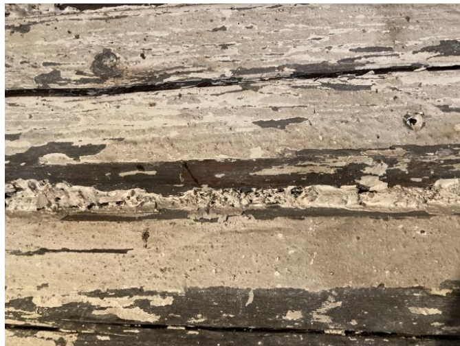
Joonis 3.22 Sahvri siseseinte viimistluskihiks on paljas palk (autori foto)
