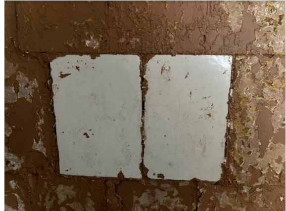
Joonis 3.42 Ahju hoolduseks tehtud avad on kaetud plaatidega (autori foto)
