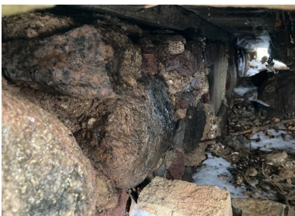
Joonis 3.3 Veranda põrandakonstruktsiooni alt vaadeldav vundamendi osa (autori foto)
