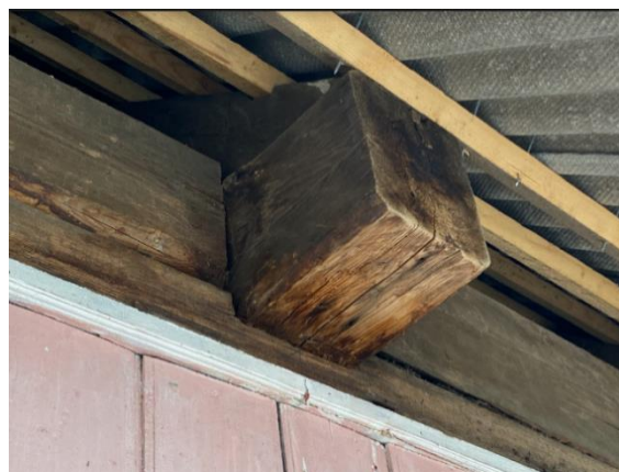
Joonis 3.27 Niiskuskahjustusega vahelaetala väljast vaadelduna (autori foto)
