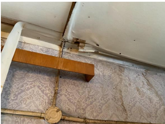
Joonis 3.19 ja 3.20 Hoone välisseina niiskuskahjustused lääneküljel (autori fotod)
