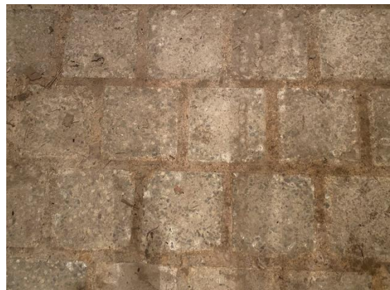
Joonis 3.10 Keldri plaaditud põrand pinnasel (autori foto)
