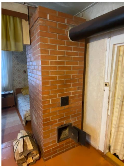
Joonis 3.37 1960ndatel juurde ehitatud ja 2000. alguses ümber ehitatud ahi (autori foto)
