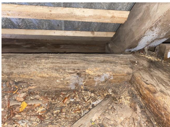
Joonis 3.26 Vahelaetalale tekkinud härmatis (autori foto)
