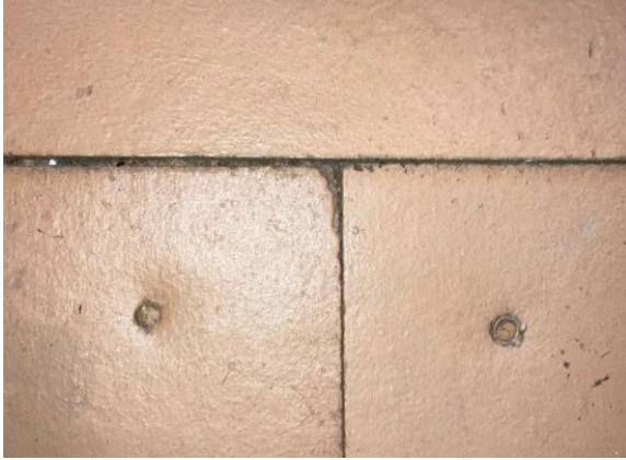
Joonis 3.14 Saepuruplaadist põrand (autori foto)
