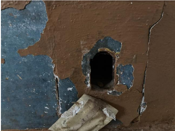
Joonis 3.41 Ahju tuulutusava (autori foto)
