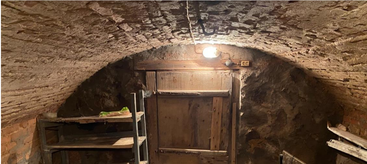
Joonis 3.11 Keldri võlvlagi (autori foto)
