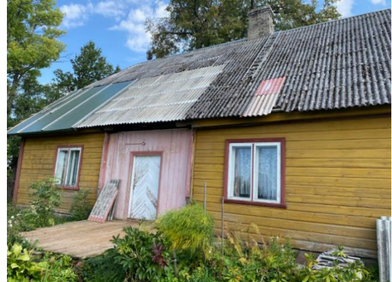
Joonis 3.32 Parandatud hoone katus (autori foto)
