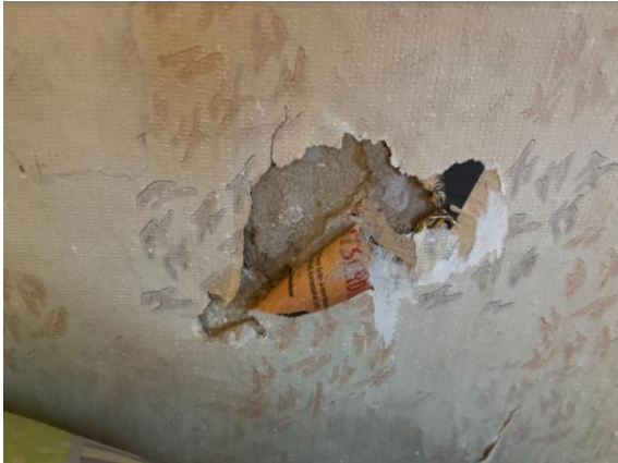
Joonis 3.20 Kahjustada saanud siseseina viimistluskiht (autori foto)
