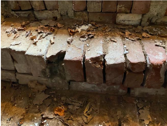
Joonis 3.7 Vajunud ja murenenud keldritrepi tellistest astmed (autori foto)
