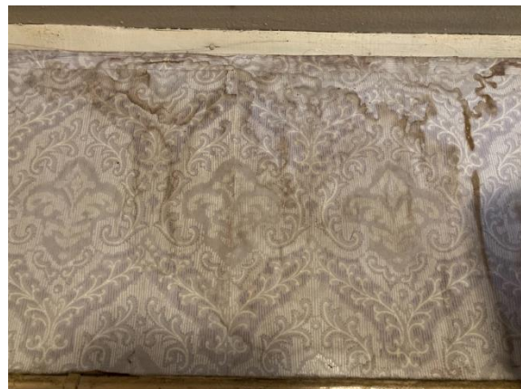
Joonis 3.19 ja 3.20 Hoone välisseina niiskuskahjustused lääneküljel (autori fotod)
