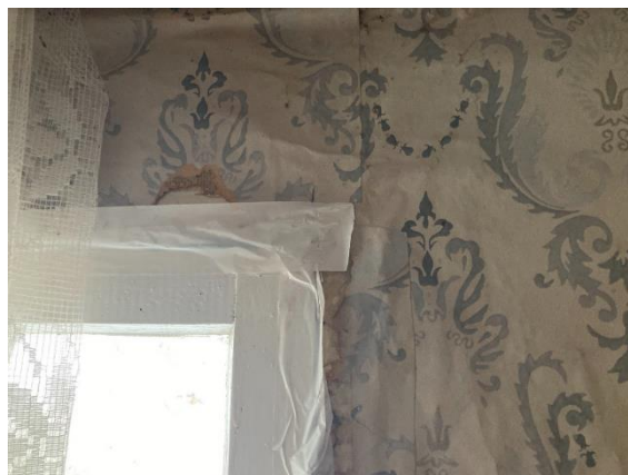
Joonis 3.34 Akna teipimine seest (autori foto)
