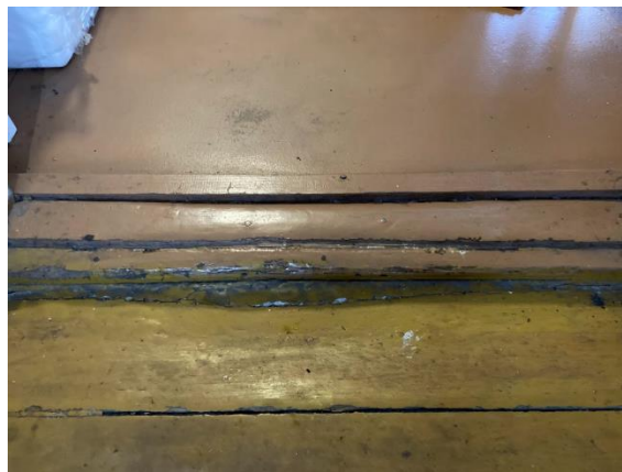
Joonis 3.16 Lohku vajunud põranda ühenduskoht seinäga (autori foto)
