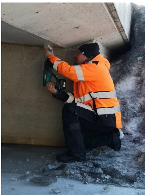
Foto 1. Töö autor välikatset läbi viimas Kintsli sillal
