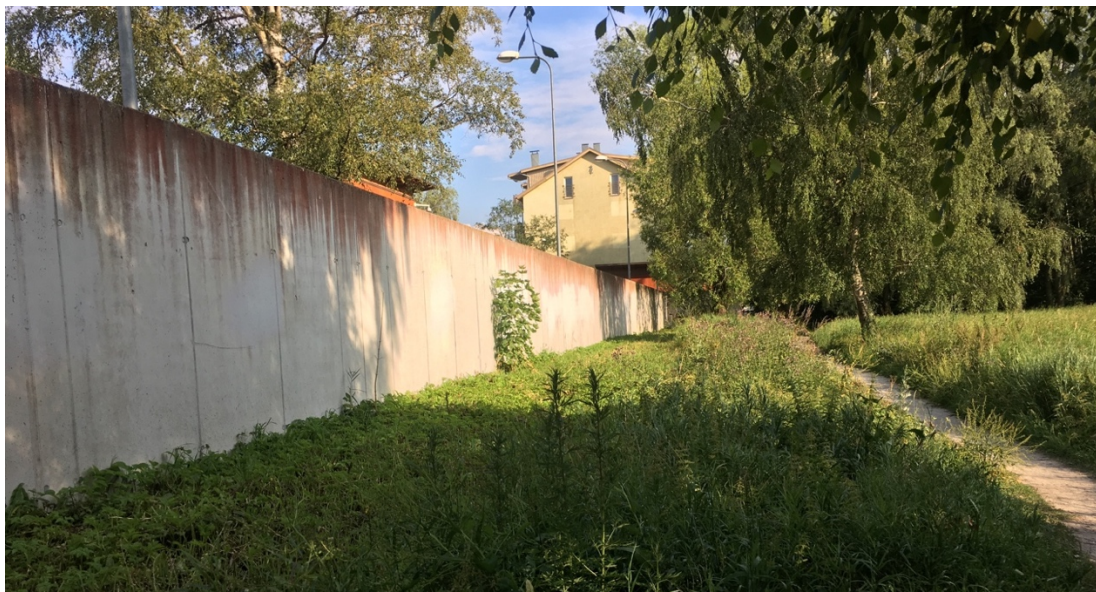
Joonis 4.6.3. Projektala idaosa ääristav betoonmüür, mille taga asub Kesklinna Politseijaoskond
