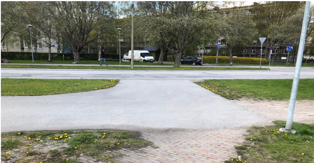
Joonis 4.6.5 Puuduv ülekäigurada sõlmpunkti juures paneb jalakäijad tegema ohtlike valikuid
