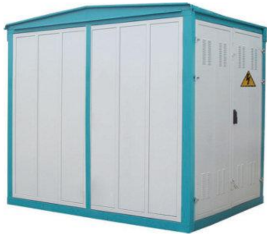
Joonis 5.1. Komplektalajaama välisvaade
