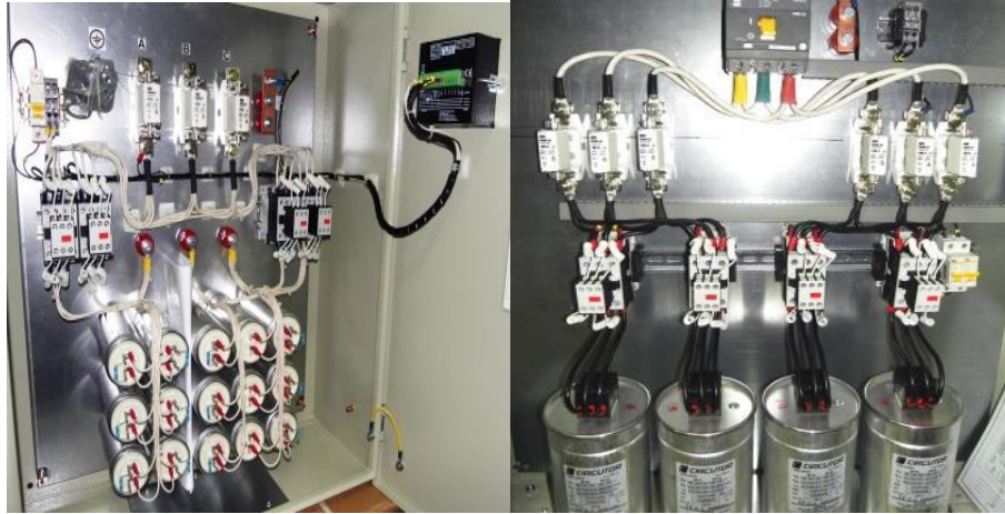
Joonis 5.3. Reaktiivvõimsuse kompenseerimisseade.
