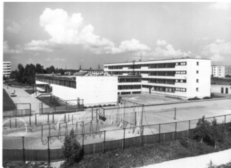
Joonis 20 – Koolimaja tüüpprojekt Lasnamäel, vaade hoonele. EP tüüpprojekt 221-1-321, arh Milvi Vainik. (Lasnamäe Vene Gümnaasium) Allikas: Eesti Arhitektuurimuseum, EAM Fk 4760
