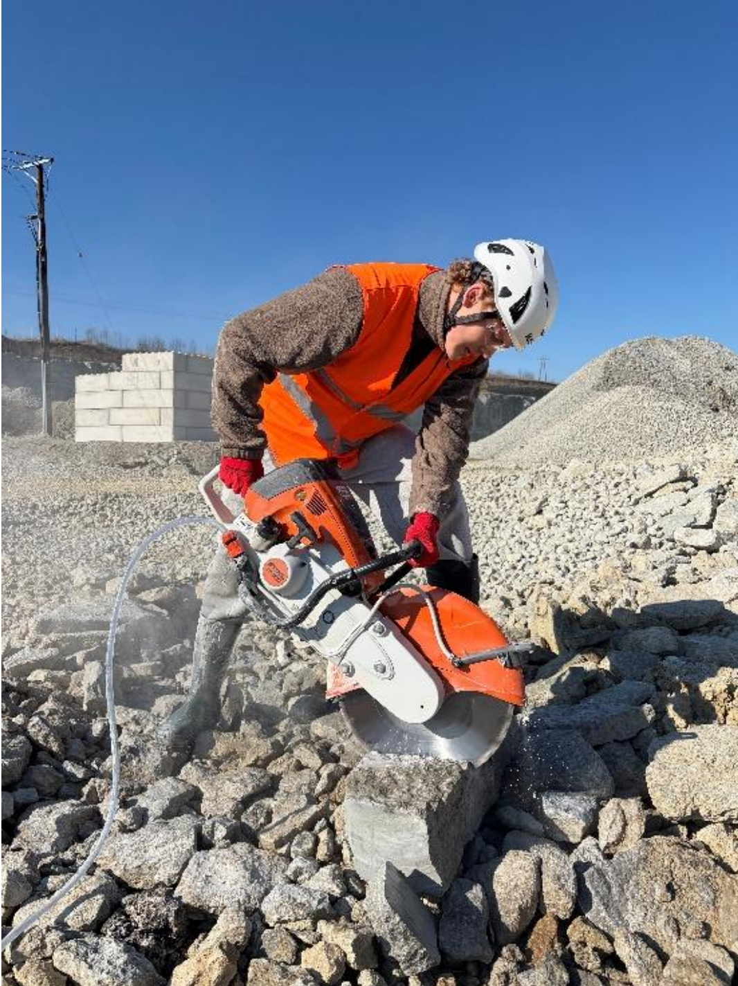
Joonis 6. Kivitüki saagimine väiksemateks tükkideks.
