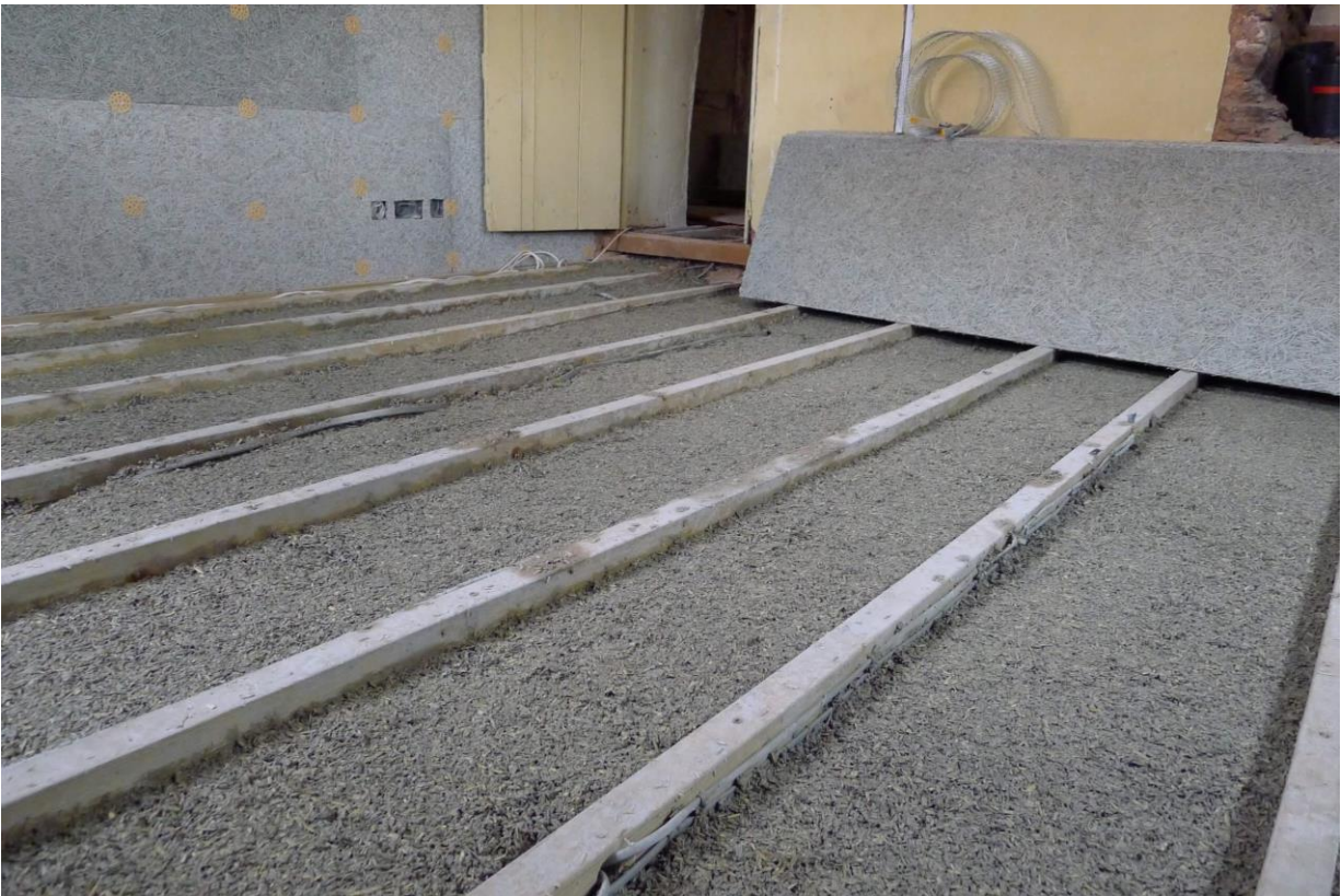
Joonis 7 Kanepibetoon põrandas[20]
