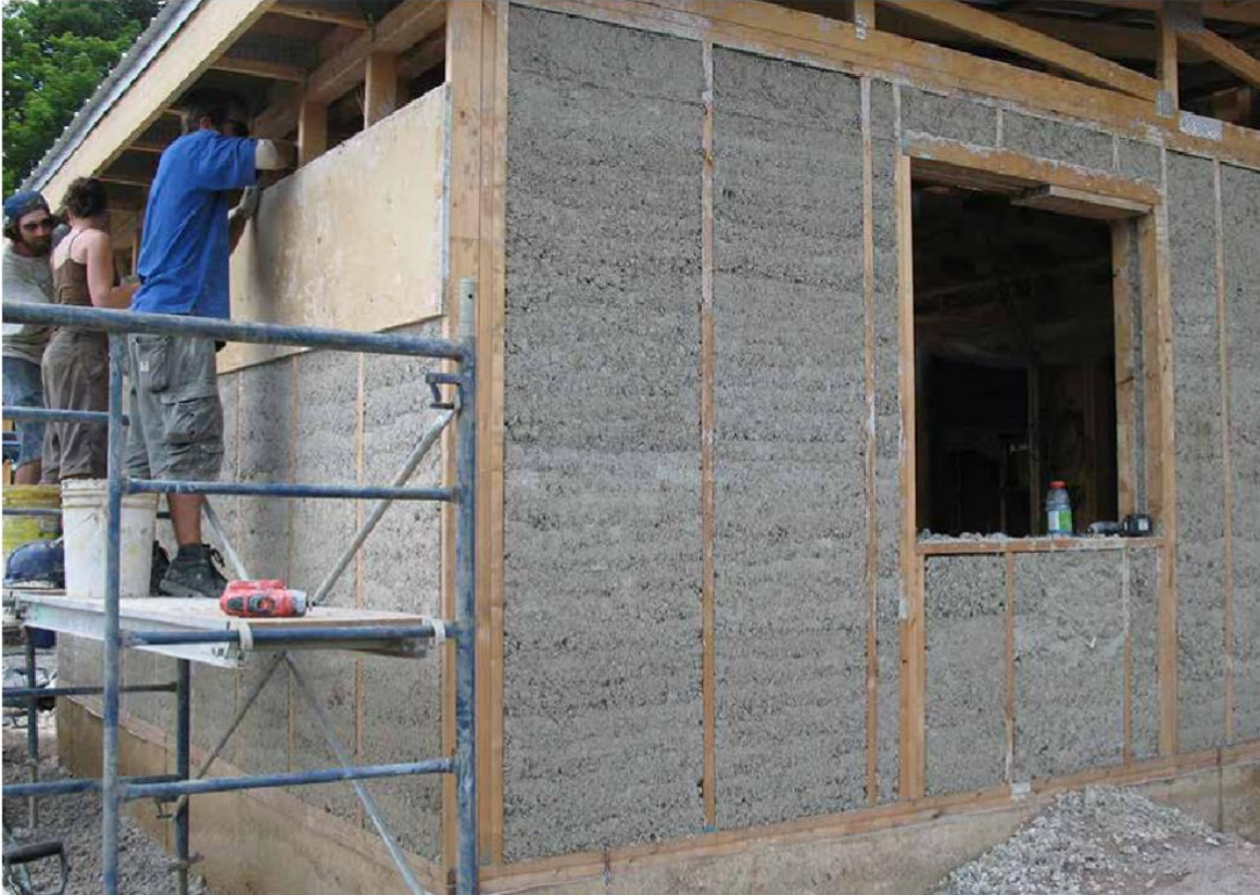
Joonis 5 Kanepibetooni paigaldamine seinä [11]
