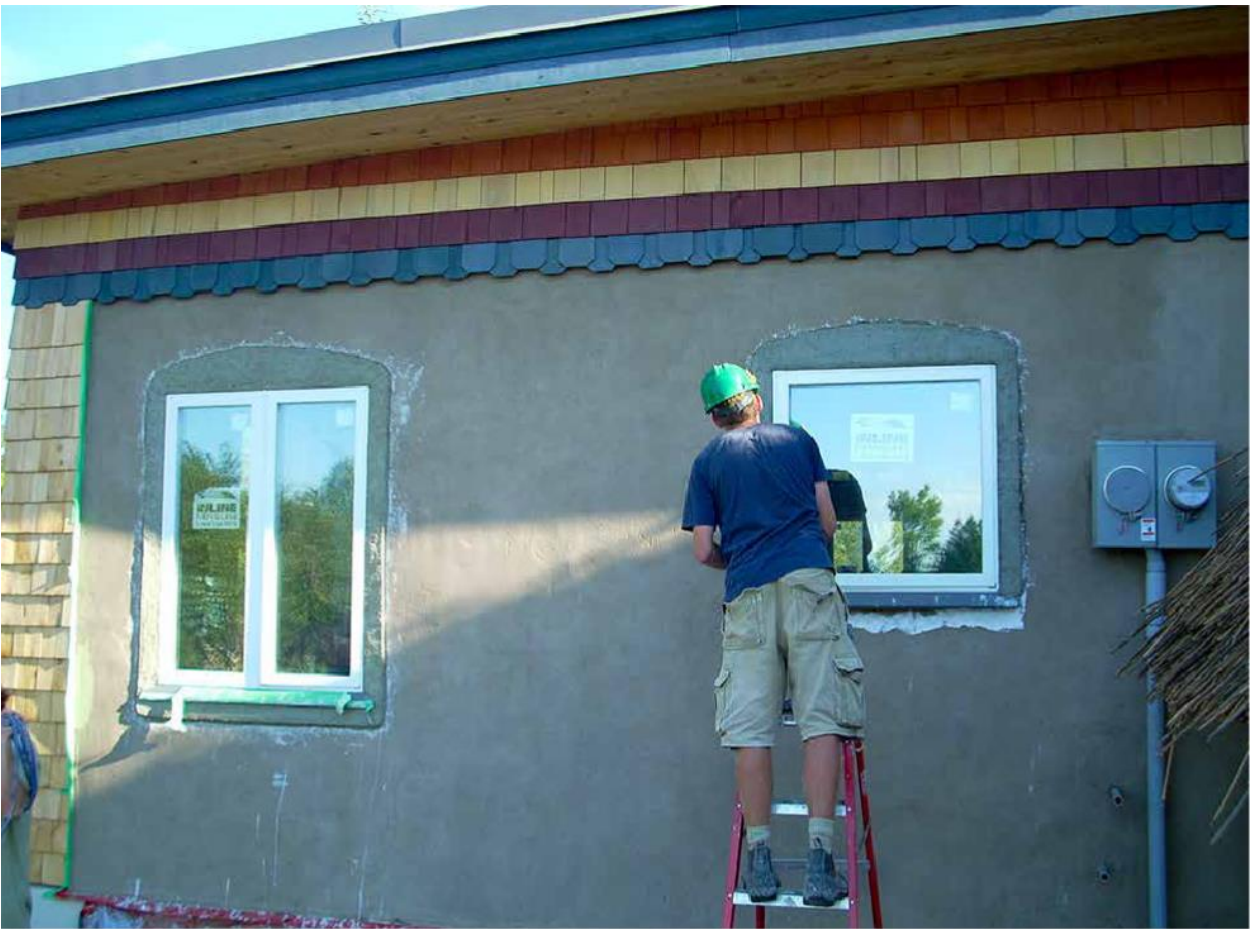
Joonis 8 akende viimistlus kanepibetooniga [11]
