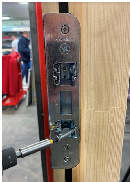
Joonis 10.5 Turvakruvi paigaldamine vasturauda
