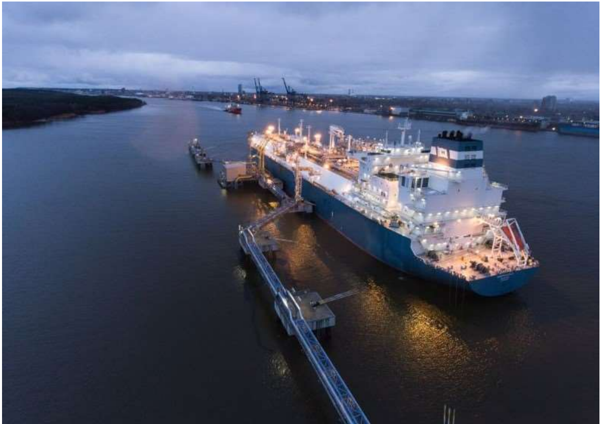
Joonis 18 Klaipeda LNG-terminal, FSRU Independence. Allikas: Klaipėdos Nafta
