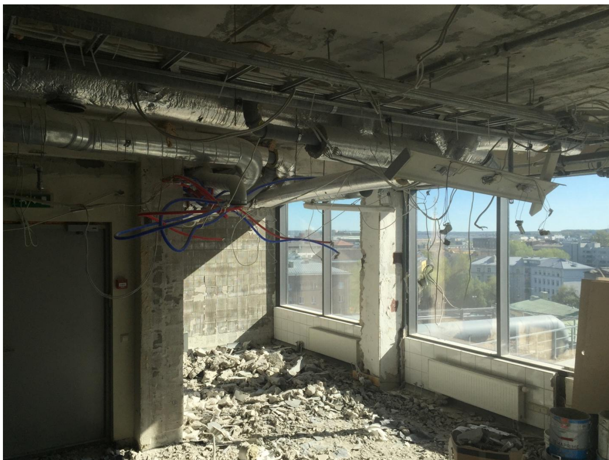
Pilt 4. Ventilatsioonisüsteemi renoveerimistööd
