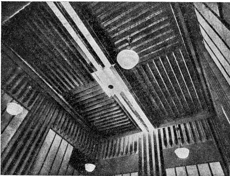
Torino saatja stuudio omapärane laekonstruksioon soovitava akustika saavutamiseks.
