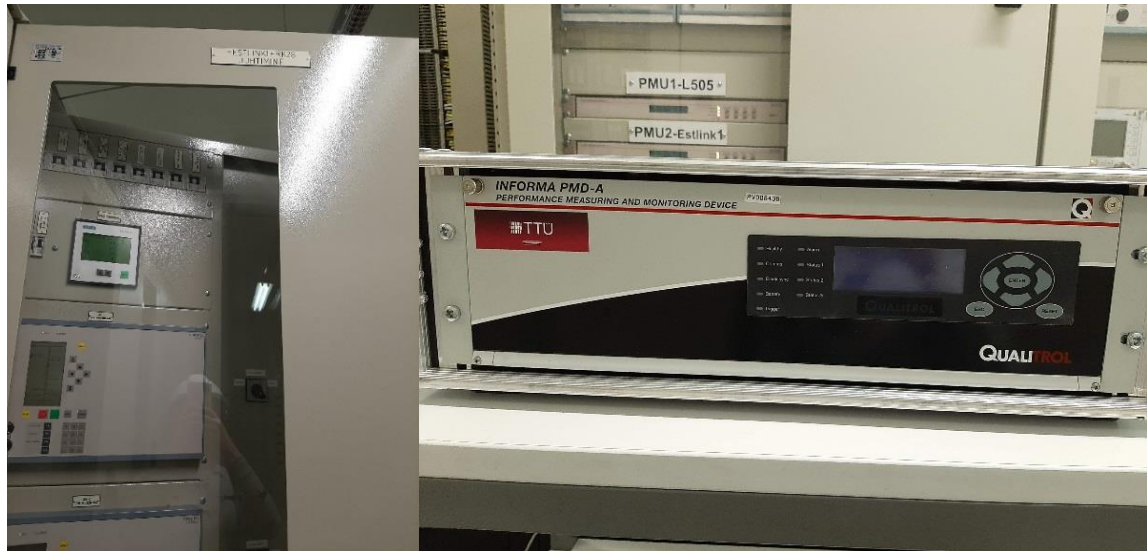
Joonis 2.3 Harku alajaamas Estlink 1 pingejaguri kamber (vasakul) ja mõõteahelasse ühendatud Qualitrol Informa PMD-A mõõteseade (paremal)
