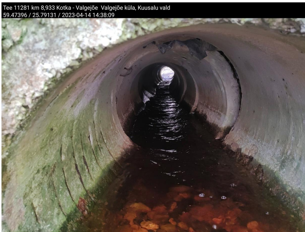
Joonis 2.4 Betontruup T11281 km 8,933. (Autori erakogu)
