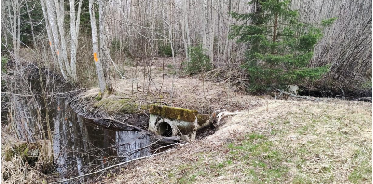
Joonis 1.6 Mahasõidu truup T11134 km 4,28. Puudub inventariandmebaasist (Autori erakogu)
