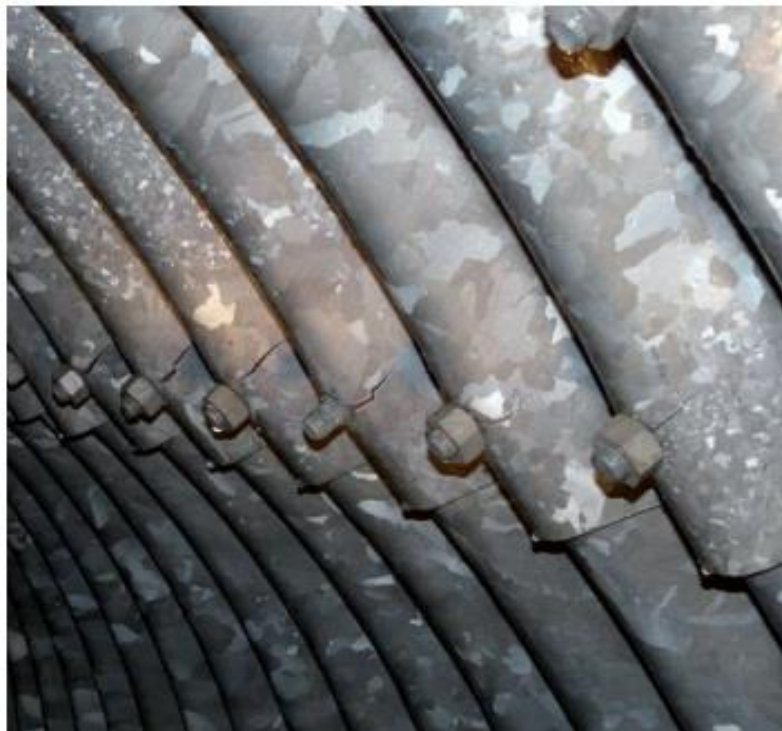
Joonis 2.7 Praod terasest truubi poldide ümber [27]
