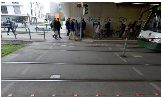
(Joonis 9 – Jalakäijaid hoiatavad tuled asfaltkatte sees) Allikas: (Guardian, 2016)
