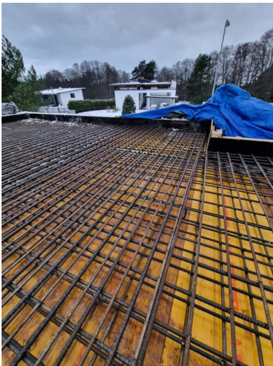
Joonis 4.10 Vahelae armeeringu teine kiht
