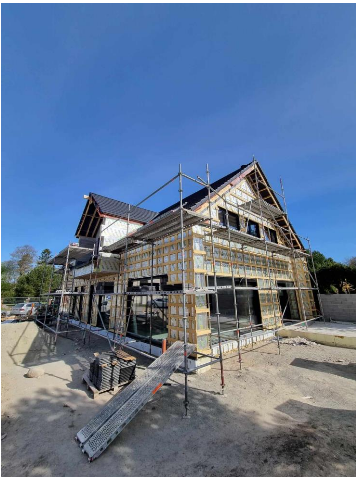
Joonis 4.17 Kurmu 10 fassaaditööd
