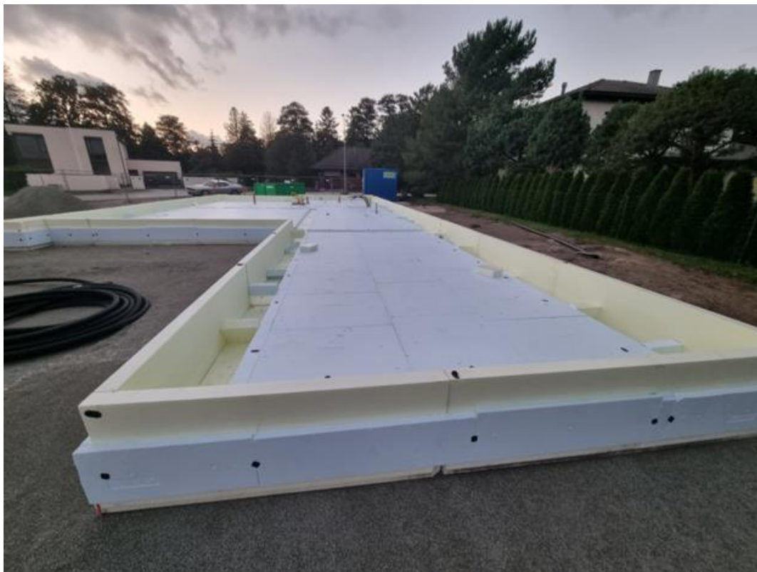
Joonis 4.3 Plaatvundamendi soojustus
