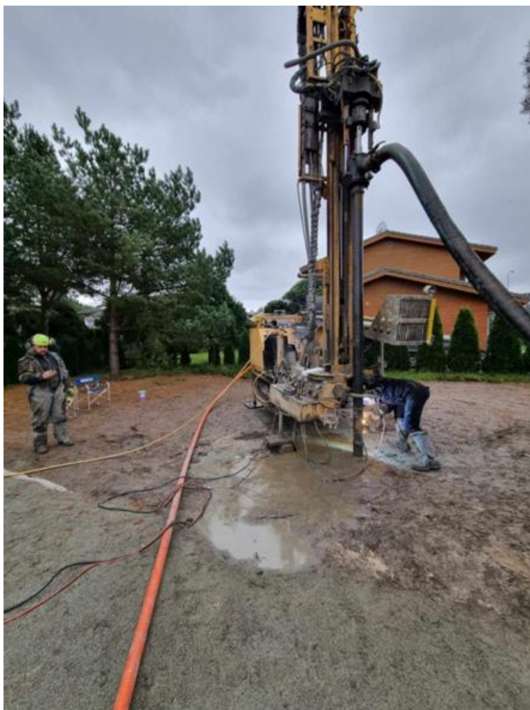
Joonis 4.1 Puurmasin ning hülsside keevitus
