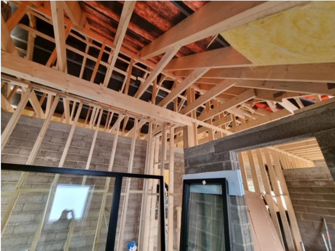
Joonis 4.13 Katuse karkass ja kandvad vaheseinad
