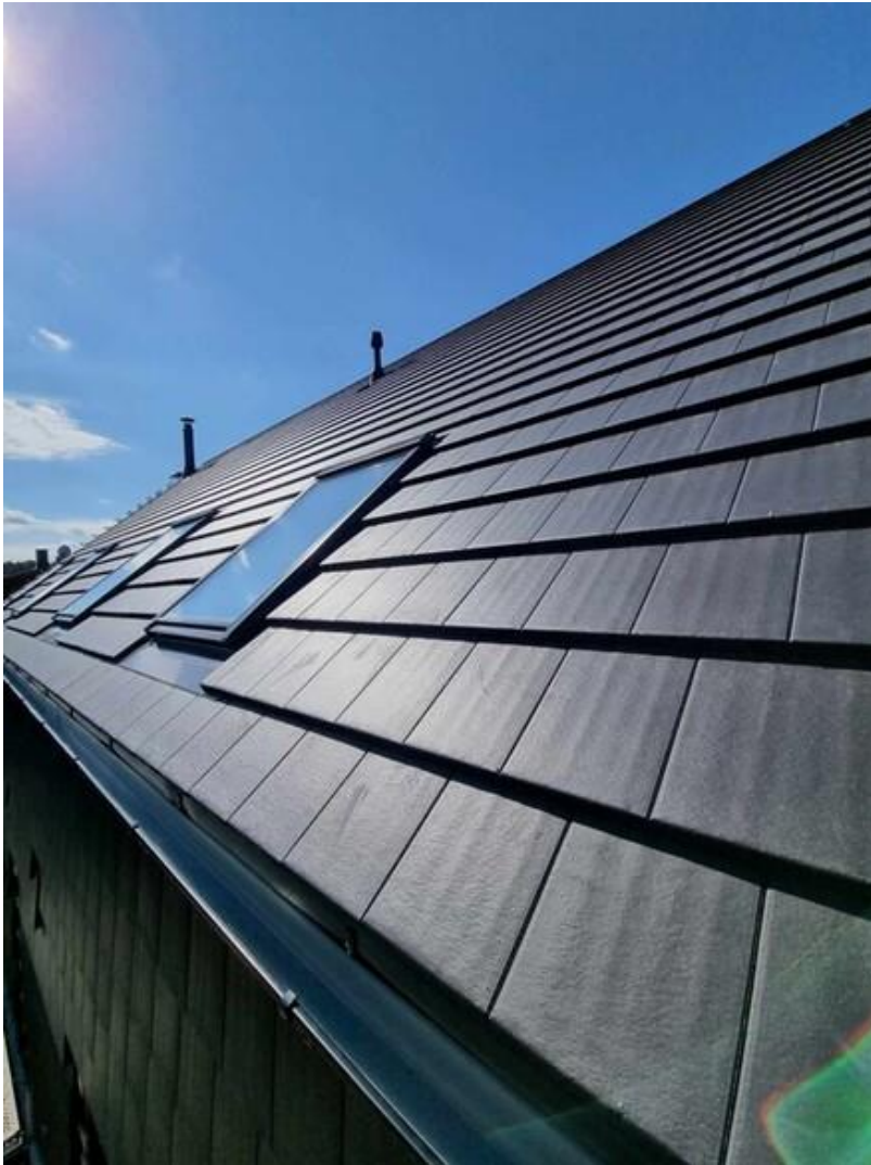
Joonis 4.15 Vaade katusele kirdest
