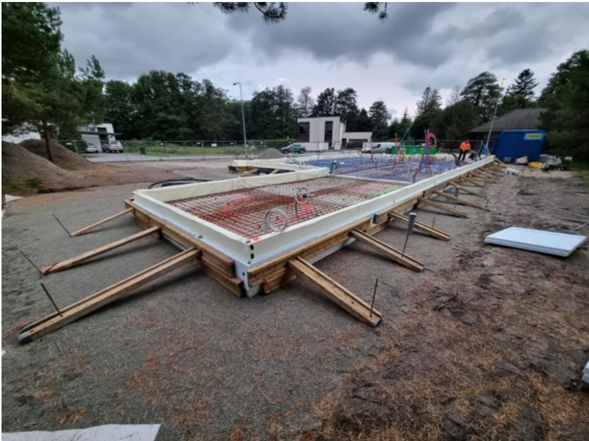
Joonis 4.4 Vundamendi armeerimine
