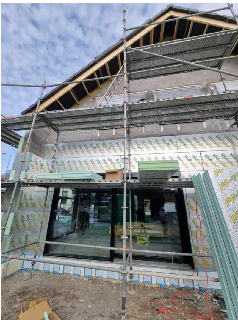
Joonis 4.16 Klima Konform aknapaigaldussüsteem
