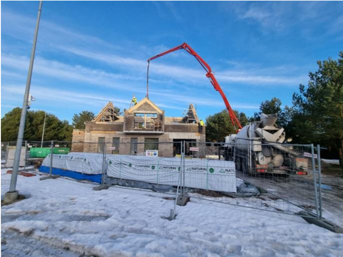
Joonis 4.12 Raudbetoonvööde betoneerimine
