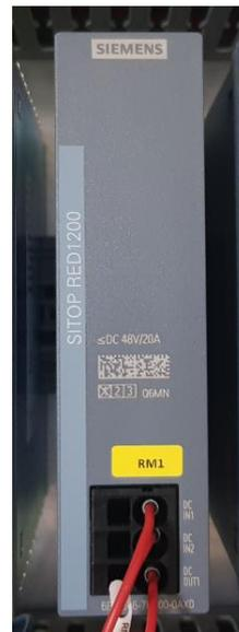
Рис. 3.2.8.1 Модуль резервирования SITOP RED1200 [33]
