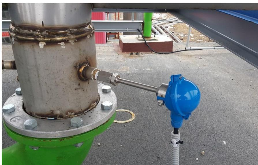
Рис. 3.1.2.2.2 Датчик с термокарманом установлен в процесс по месту
