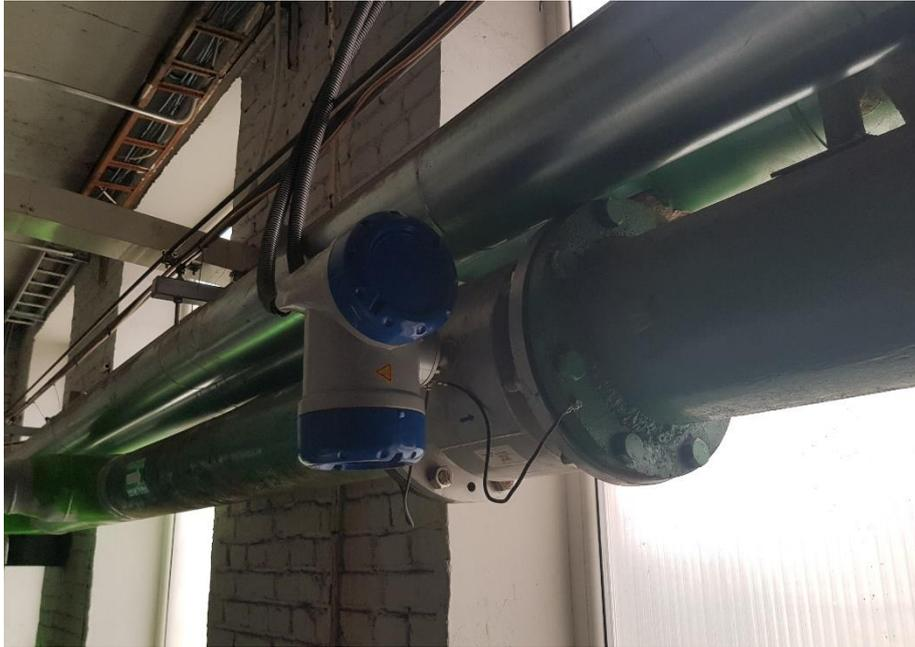
Рис.3.1.3.2.1 Монтаж расходомера по месту
