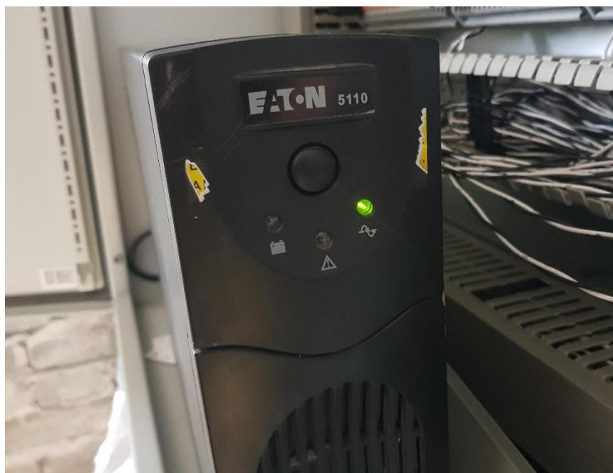
Рис. 3.2.9.1 ИБП в шкафу УСО по месту
