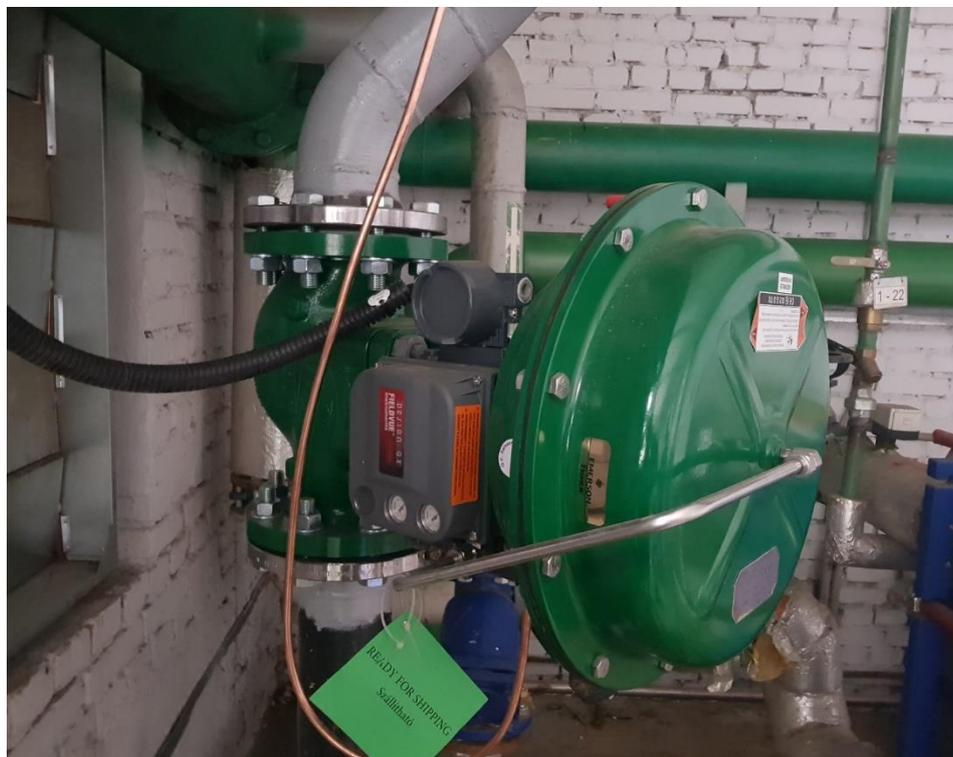
Рис.3.1.6.2.1 Монтаж клапана по месту
