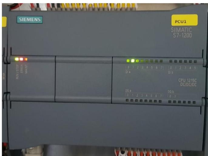
Рис. 3.2.1.1 Контроллер S7-1200 CPU1215C по месту
