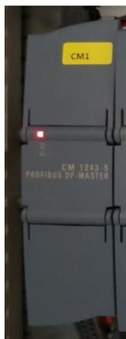
Рис. 3.2.2.1 Коммуникационный модуль CM 1243-5 PROFIBUS DP-Master по месту
