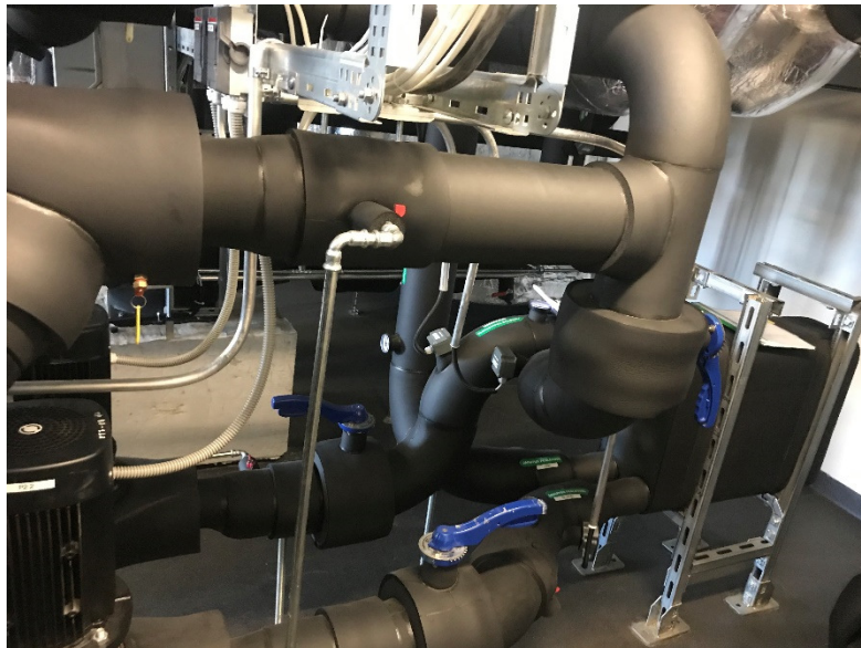
Joonis 1.4. KM2 vabajahutuse soojusvaheti
