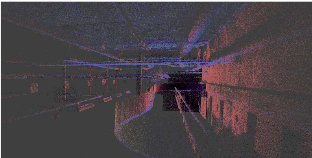
Joonis 6.27. GeoSLAM ZEB-FARO punktipilv vaatega keskuse lae alla, lambisiinid ja ventilatsioonitorud on punktipilves tuvastatavad (AutoCAD tarkvaras)
