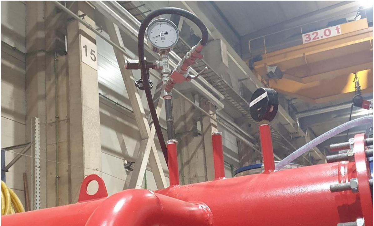
Joonis 5.3 Katsestendi rõhu pumpamine
