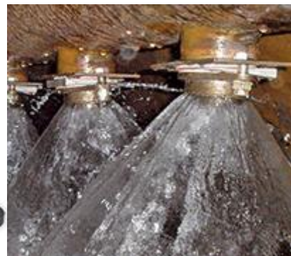
Joonis 3.3 Vasakult vedrupeaga pihusti joonis, vedrupeaga pihusti ja pihustusmuster [16] [17]
