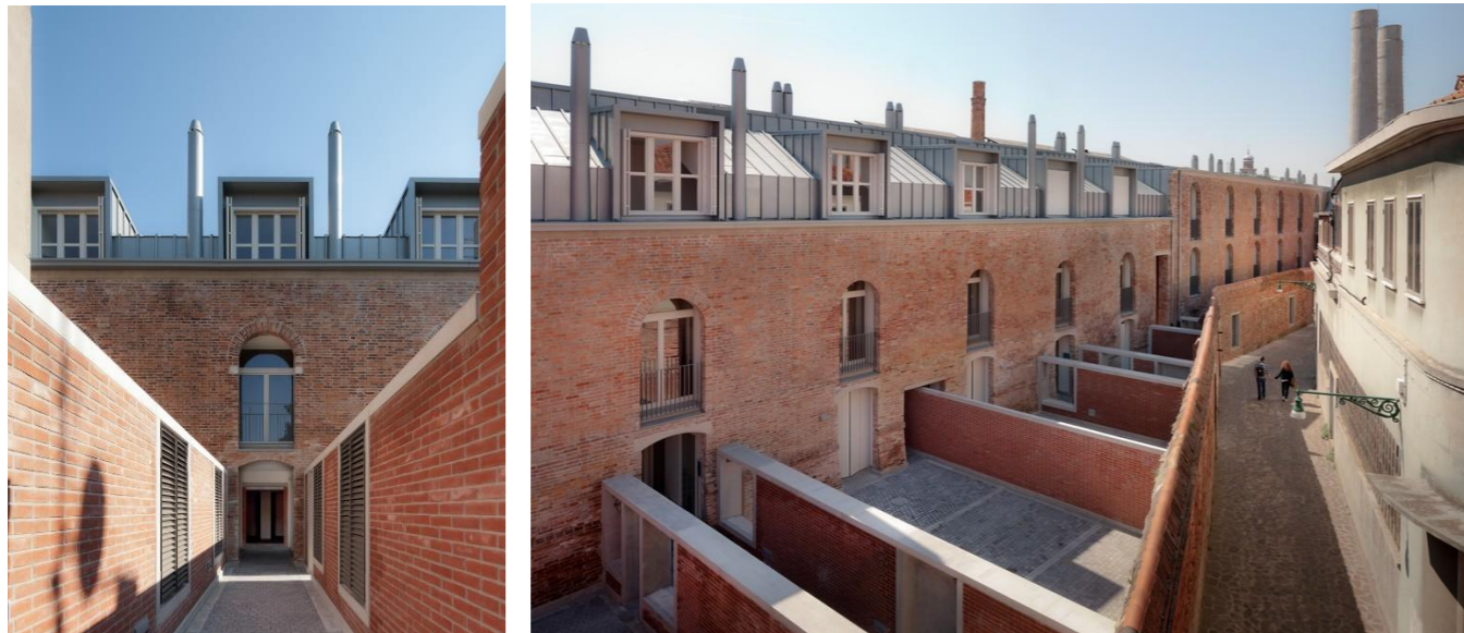
(Foto 3. ja 4. Vaated renoveeritud Conterie tehasehoonetele. Autor: Marco Zanta)
