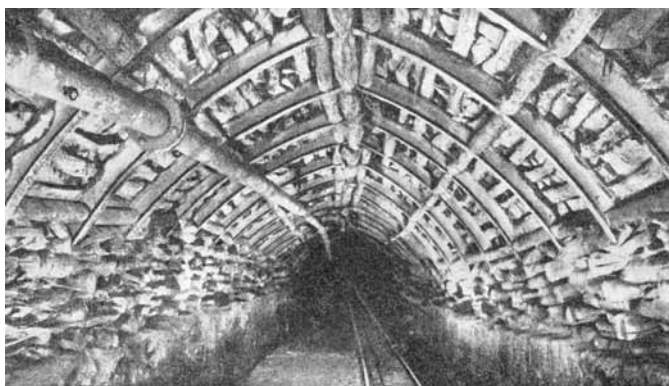
Joon. 6. Viisnurkse põiklõikega järeleandlik koristuskäigu segatoestik söekaevanduses.
