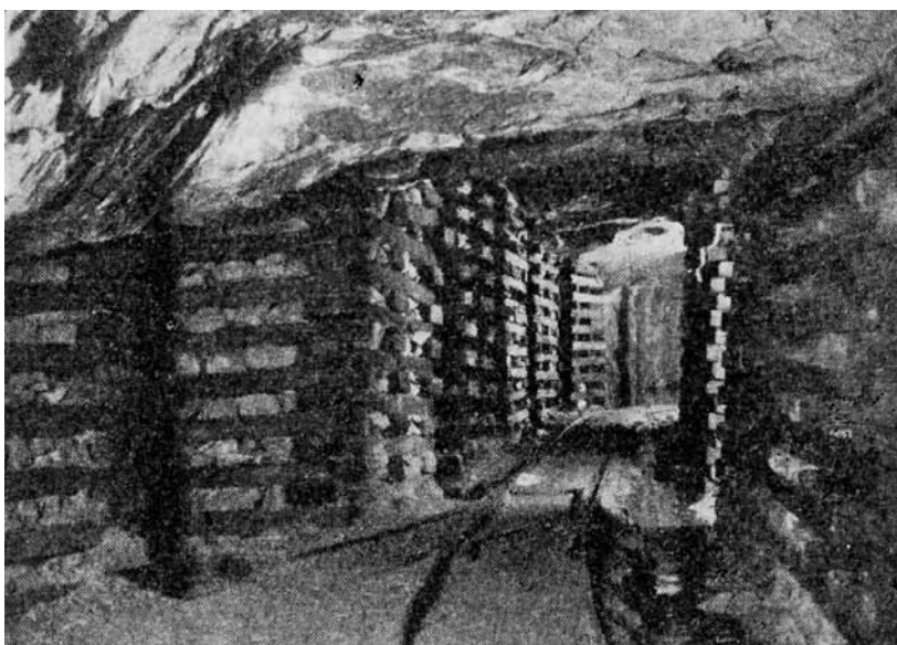
Joon. 9. Koristuskäigu toestamine täidetud riitadega suurerõhumise ja tugeva lae puhul.
