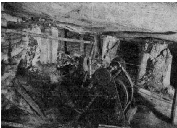
Joon. 2. Ühtlaselt allatuleva lae poolt puruksmuljutud massiivsed betoonsambad 1500 m sügavusega kaevanduses.
