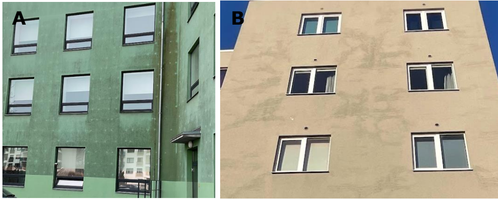
Joonis 4.44 Värvide ja esteetika kahjustused värvilistel fassaadidel A) mikroorganismide kasvamine, B) muud värvimuutused (Allikas: autori erakogu)
