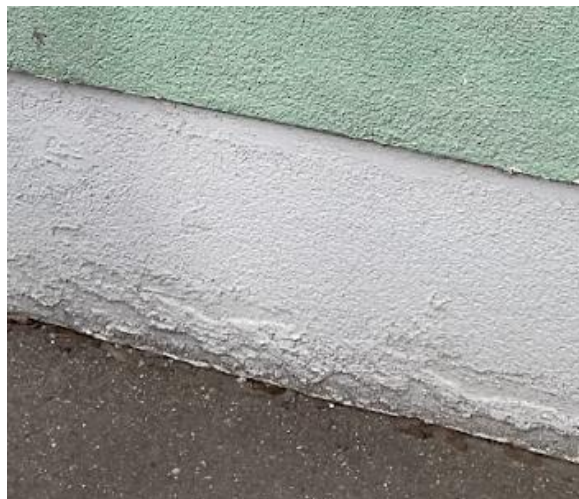
Joonis 4.39 Ebatasasused sokli pinnal (Allikas: autori erakogu)
