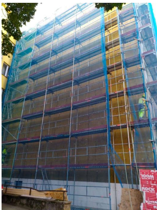
Joonis 1.2 Nõuetele vastav tellingute ja kaitsetelgiga SILS süsteemi paigaldus [22]
