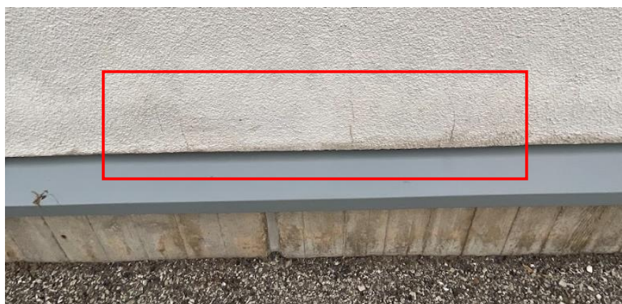
Joonis 4.16 Sokliprofiilist algavad praod (Allikas: autori erakogu)
