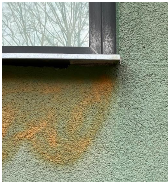
Joonis 4.49 Korrosioon SILS süsteemil (Allikas: autori erakogu)
