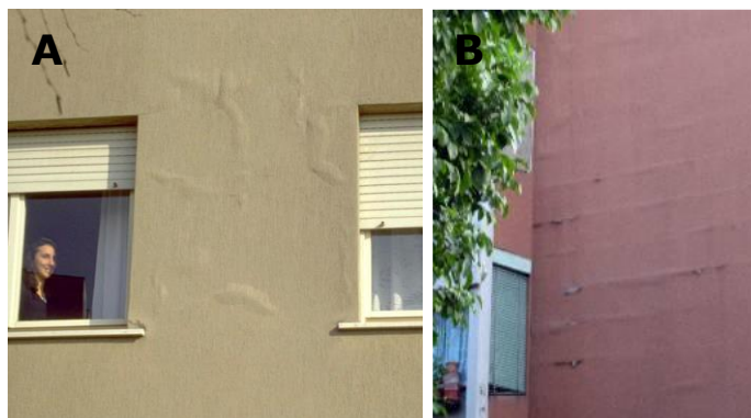
Joonis 1.12 A) Viimistluskihi pundumine B) Soojusisolatsiooniplaatide vaheliste vuukide nähtavus [27]
