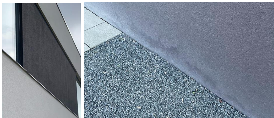
Joonis 4.67 Muud värvimuutused tumedatel fassaadidel (Allikas: autori erakogu)
