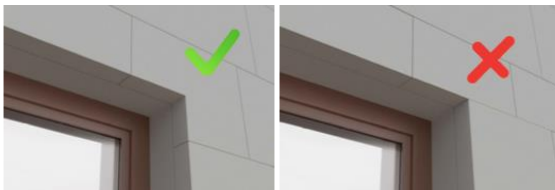
Joonis 1.4 Soojusisolatsiooniplaatide paigaldus [11]
