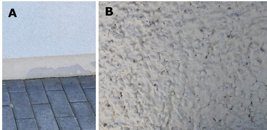
Joonis 4.12 Sokli piirkonna pinnakahjustused A) Viimistluskihi eraldumine, B) Piirkonnapõhised praod
