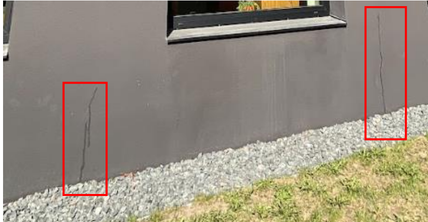
Joonis 4.65 Piirkonnapõhised praod tumedal fassaadil (Allikas: autori erakogu)
