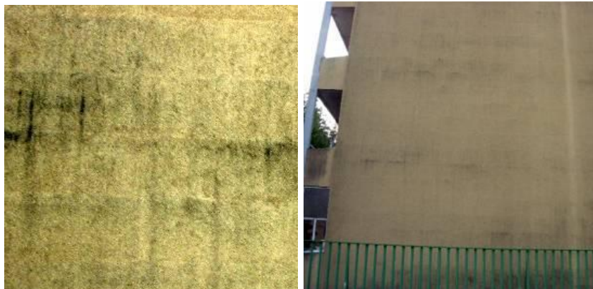
Joonis 1.7 Mikrobioloogilise kasvamisega kahjustunud fassaadid [27]
