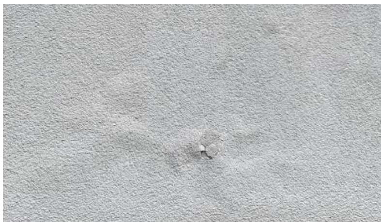
Joonis 4.20 Viimistluskihi pundumine (Allikas: autori erakogu)
