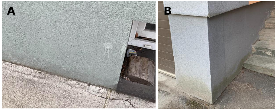
Joonis 4.38 Värvide ja esteetika kahjustused soklil A) muud värvimuutused, B) mikrobioloogiline kasvamine (Allikas: autori erakogu)
