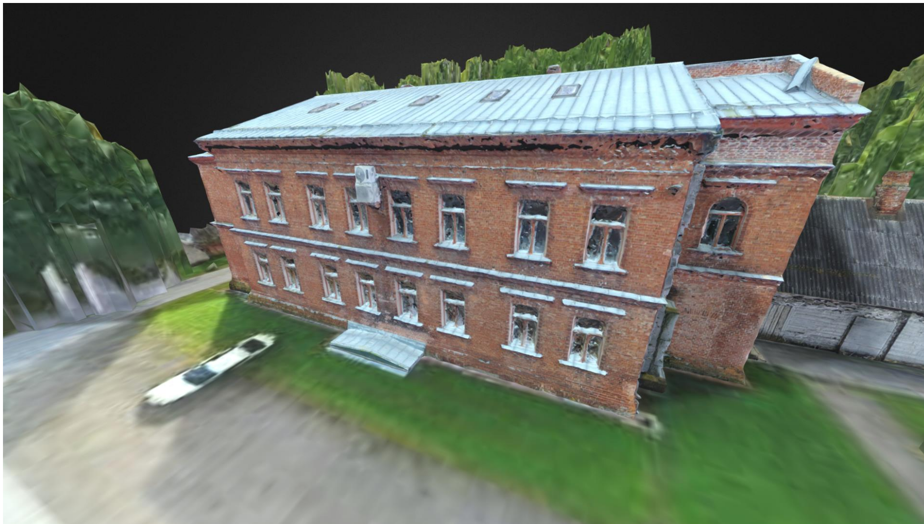
Lisa 1 A-korpuse hoone Puiestee muruplatsi poolne fassaad
