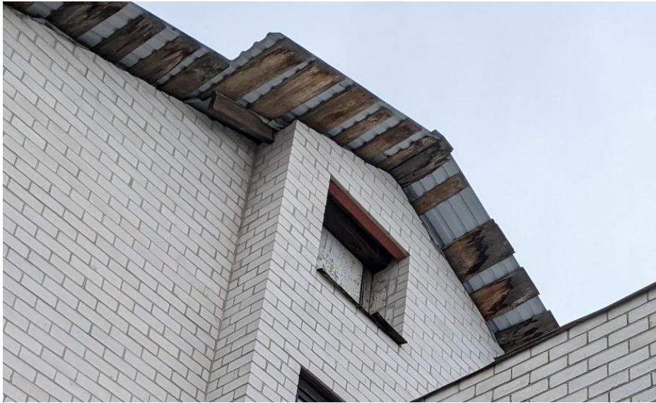
Joonis 3.12 Niiskuskahjustused roovlaudade otstes (autori foto)
