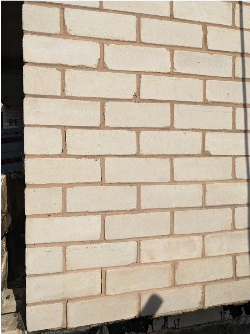
Joonis 3.7 Pragu tellismüüritises (autori foto)
