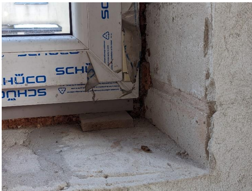
Joonis 3.16 Akna paigaldamisel pole kasutatud tihendusteipe (autori foto)
