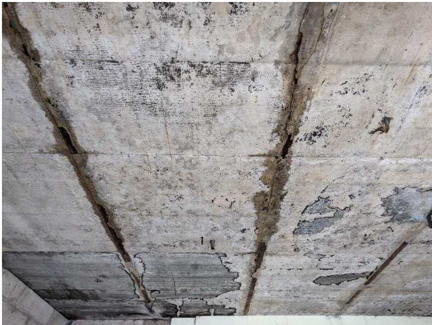
Joonis 3.14 Teise korruse veranda kahjustunud lagi, mille kohal asub kolmanda korruse rõdu (autori foto)
