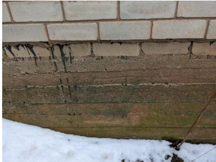
Joonis 3.2 Vetikakahjustusega sokkel hoone põhjapoolses osas (autori foto)
