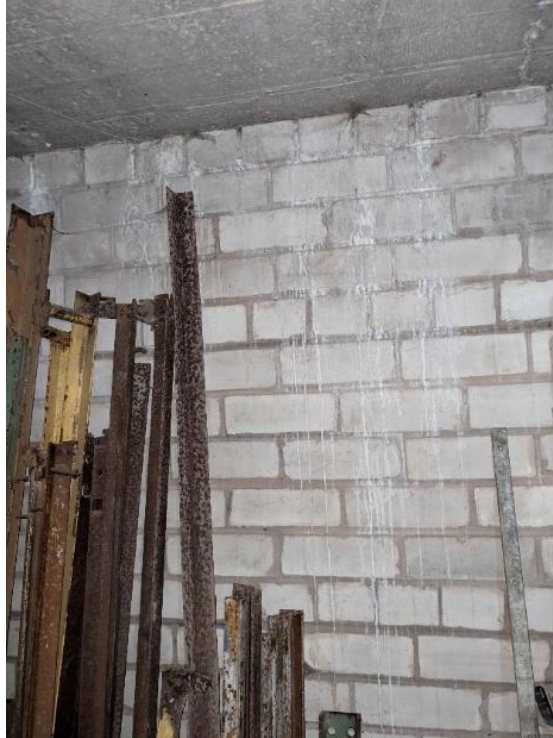
Joonis 3.4 Efloresents keldriseinas (autori foto)
