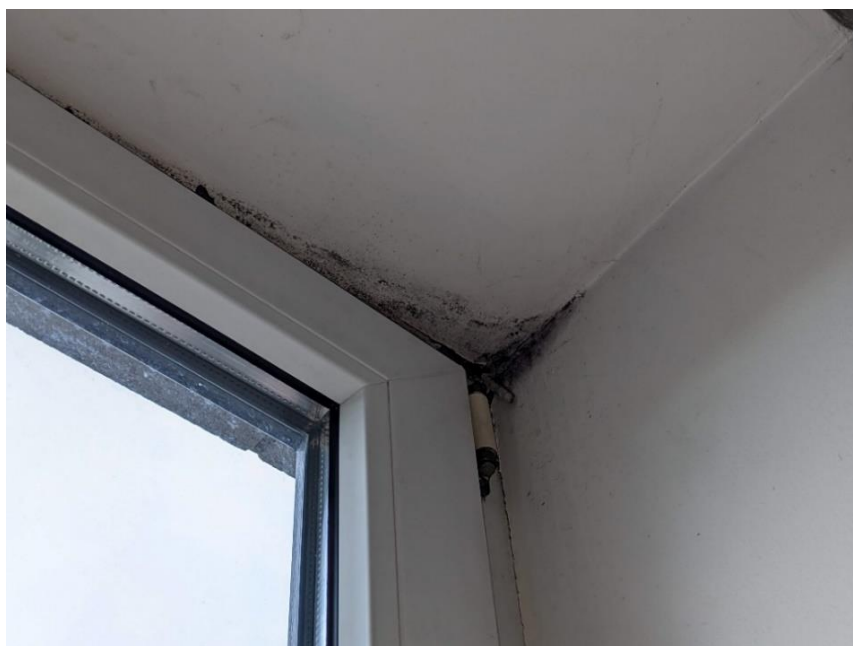
Joonis 3.18 Rõduukse nurgas esineb hallitust, mis on tingitud külmasillast (autori foto)
