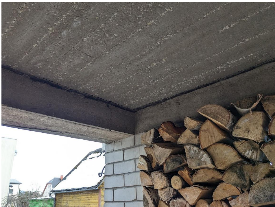
Joonis 3.10 Välisukse juures oleva veranda raudbetoonlagi (autori foto)
