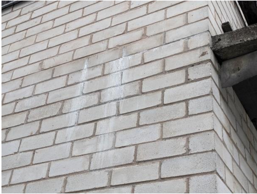
Joonis 3.5 Efloresents tellismüüritisel (autori foto)
