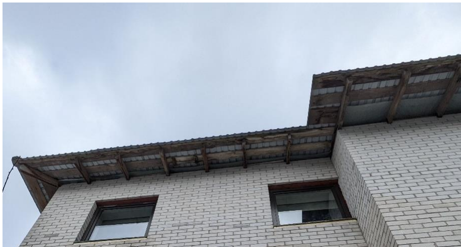
Joonis 3.13 Vihmaveesüsteemi ja tuulekasti puudumine (autori foto)
