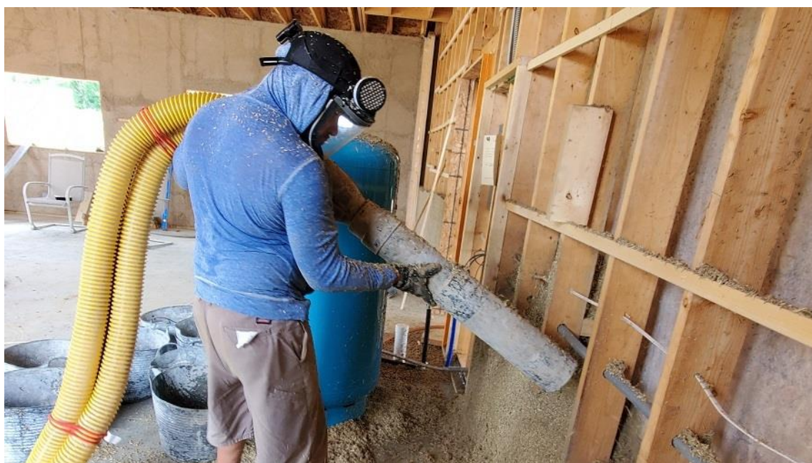
Joonis 1.2 Pihustamismeetodiga kanepibetooni paigaldamine [22]
