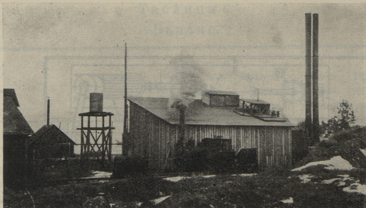
Рис. 3. Общий вид пробного завода.
