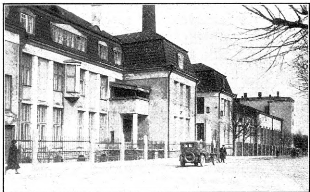
Tallinna linna elektrijaama üldvaade.
