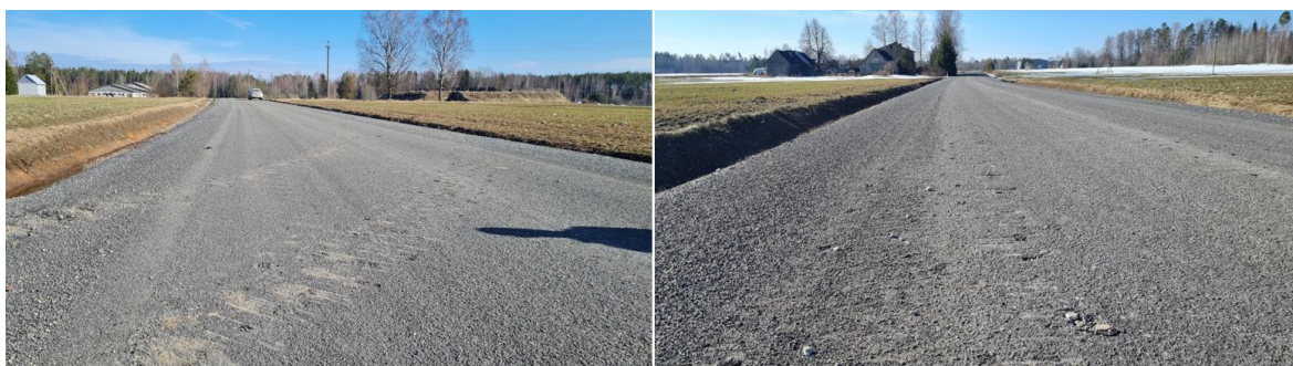
Joonis 3. 14 Pinnatud teekatte seisukord lume sulamise järgselt
