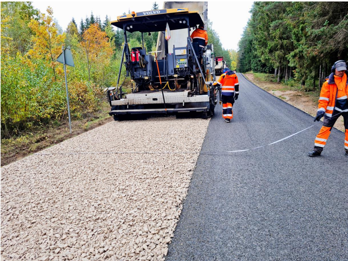
Bimac katte rajamine: immutuskilustiku põhifraktsiooni laotamine – teine paan, pikivuuk
