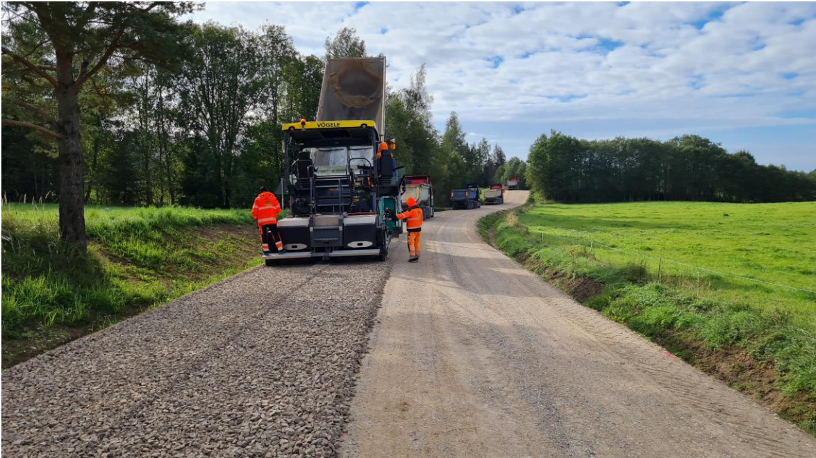
Bimac katte rajamine: immutuskilustiku põhifraktsiooni laotamine
