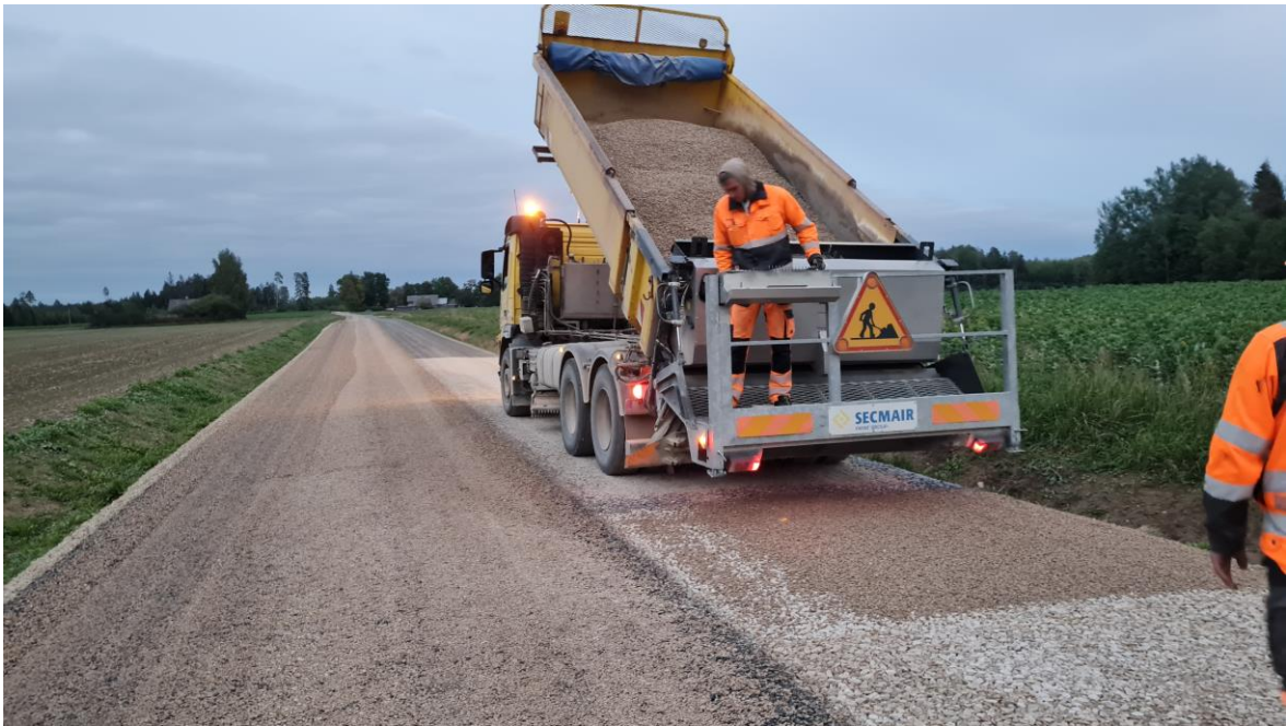
Bimac katte rajamine: immutusküllustiku põhifraktsiooni kiilumine
