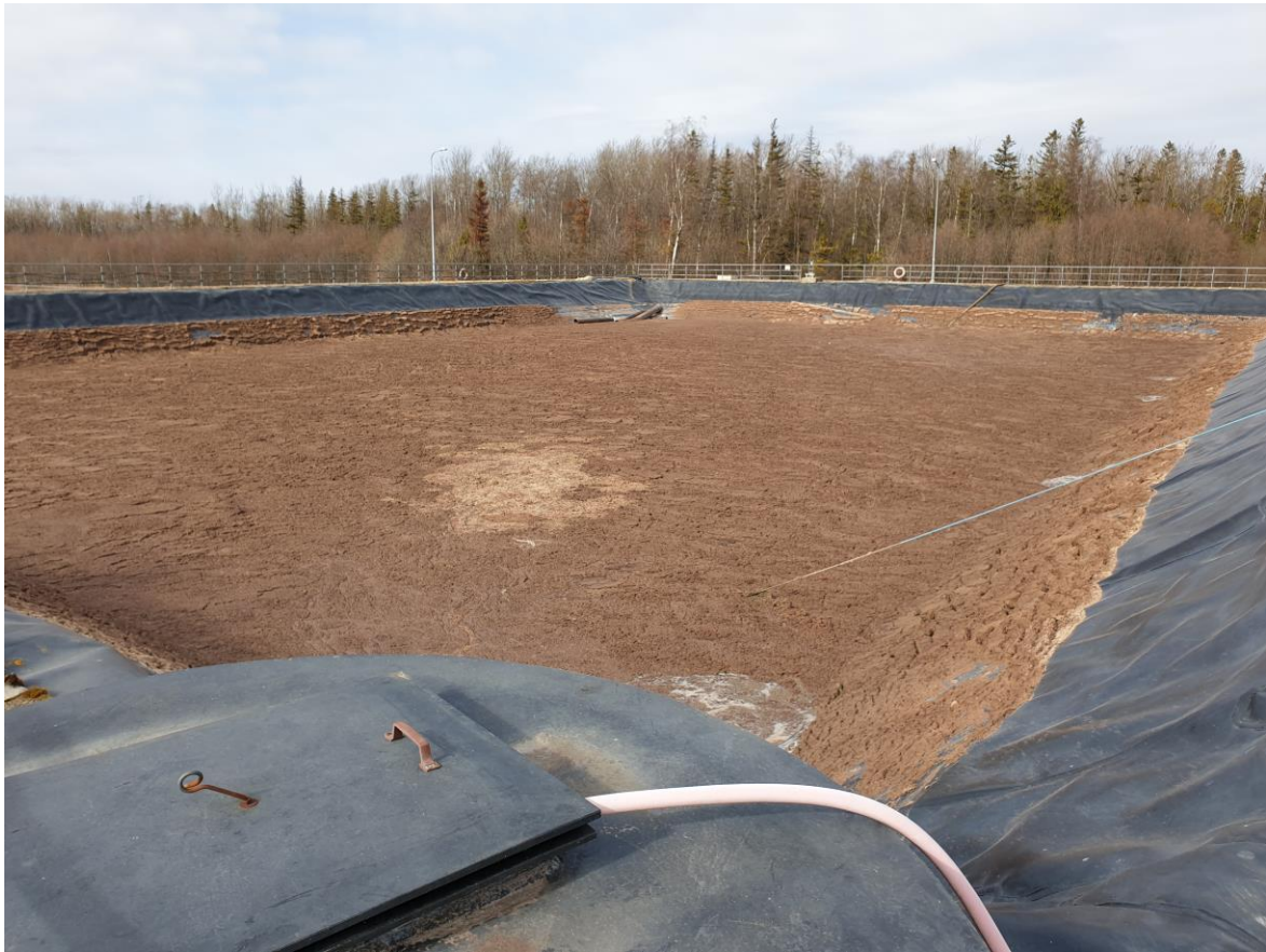
Joonis 3.2 Autori foto, tehtud 26.03.2019. Pumplast juhitakse sademevesi sademevee hoidlasse
