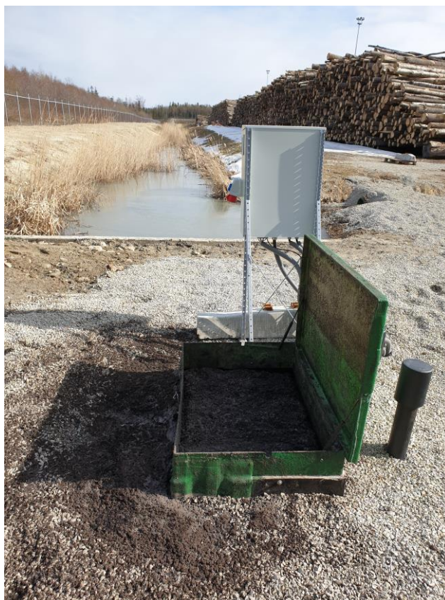
Joonis 3.1 Autori foto, tehtud 26.03.2019. Rajatud sademevee pumpla
