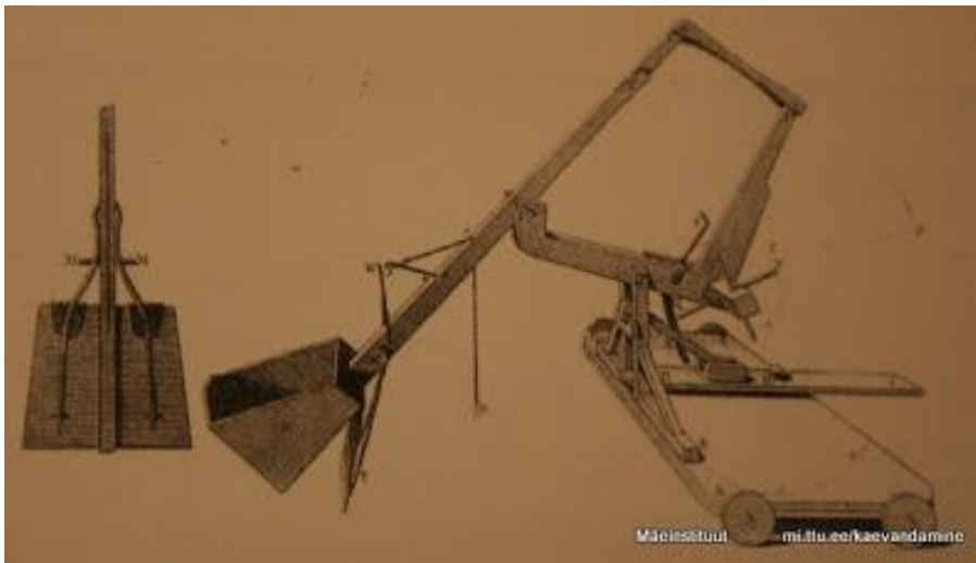
Joonis 2-10 Dubois põhjaluugiga pärikoppekskavaator [4]
