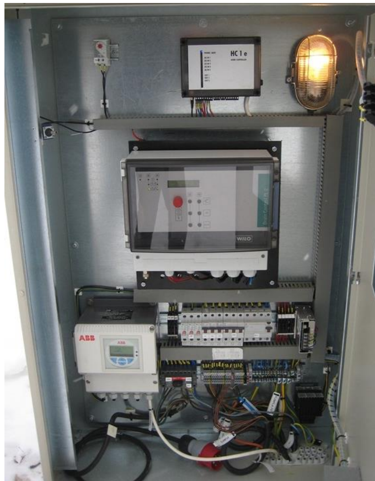
Joonis 3. Juhtautomaatika kilp 2000 seeria Strong pumplal [11].
