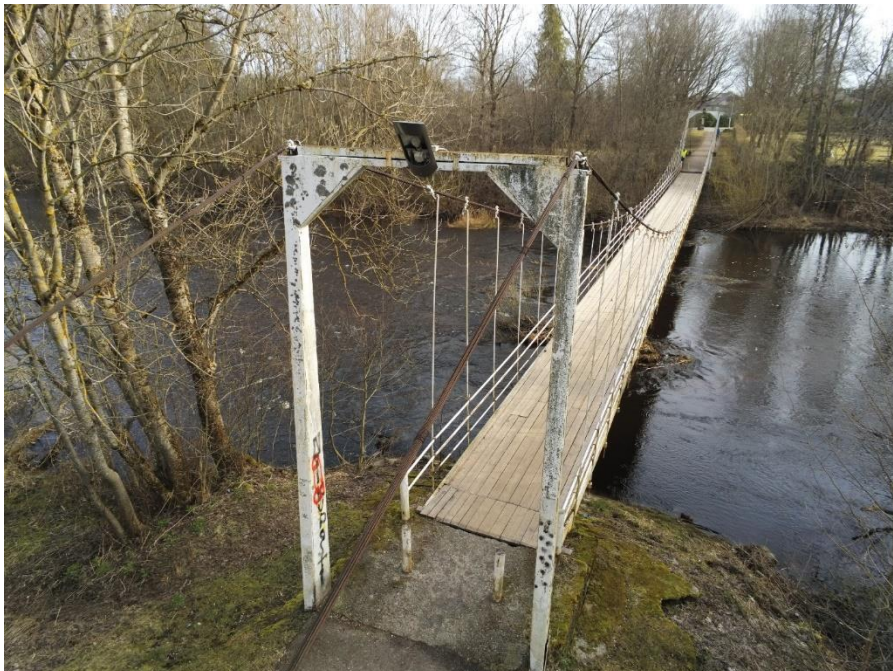
Joonis 2. Lagedi ripsilla konstruktsioonide seisukorra uurimistöö
