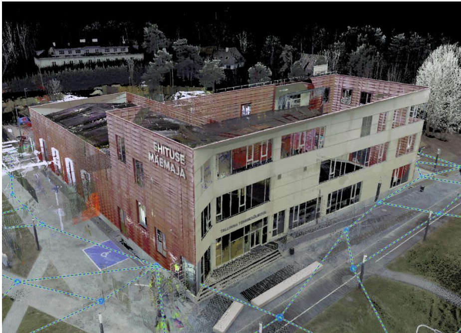
Joonis 1. Renoveeritud Mäepealse laborimaja fassaadi laserskaneerimise tulemus.
