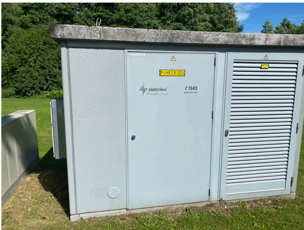
Joonis 1.7 Puhkekeskuse 400A madalpinge liitumispunkt asub 10/0,4 kV alajaamas Õru kinnistu lõuna piiril maantee ääres.
