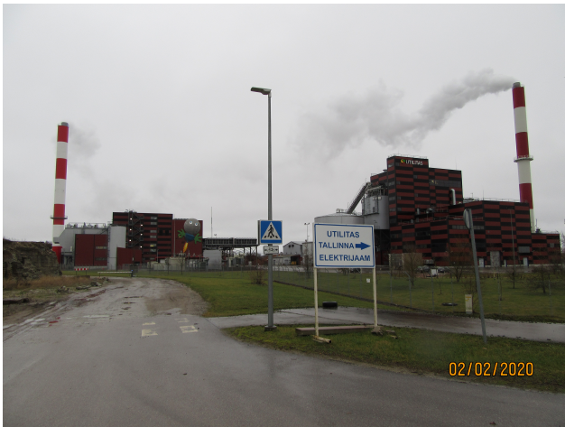
Foto 12 AS Utilitase Tallinna elektrijaam (autori foto)
