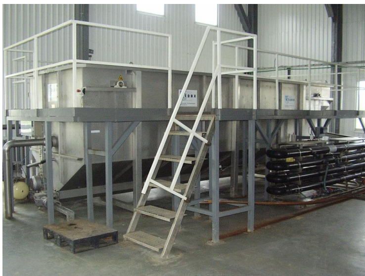
Joonis 14. Flotaator ja flokulaator. [26]
