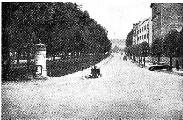
Asfalt-betoon „Topeka“ kate Kaarli puiesteel.
