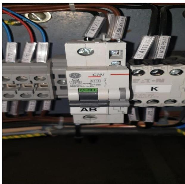
Рисунок 2.6. Автомат General electric g101 c2
