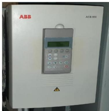
Рисунок 2.7. Частотный преобразователь ABB ACS600
