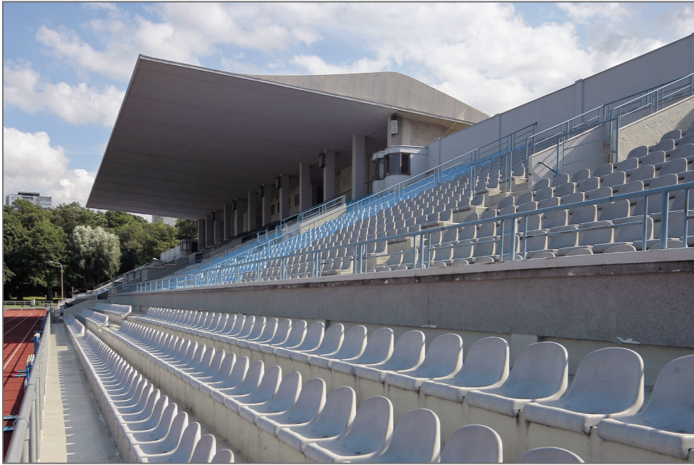
Kadrioru staadioni tribüün konsoole varikatusega (arhitekt Elmar Lohk, 1937). Foto autor: Martin Siplane
