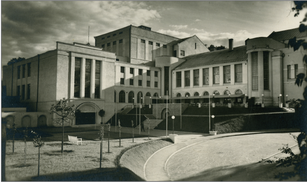
Teater „Vanemuine“ (arhitekt Armas Lindgren, 1906. Juurdeehitus: arhitektid Arnold Matteus, Elmar Lohk, 1937–1939). Allikas: Eesti Arhitektuurimuseum
