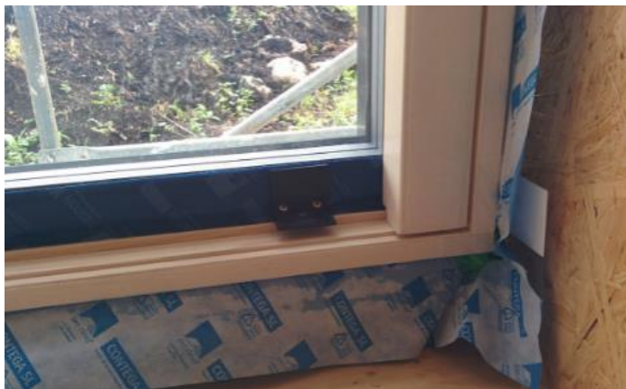
Joonis 7.6 Korrektselt teibitud akna õhutõkkekihi liitekohad [2]
