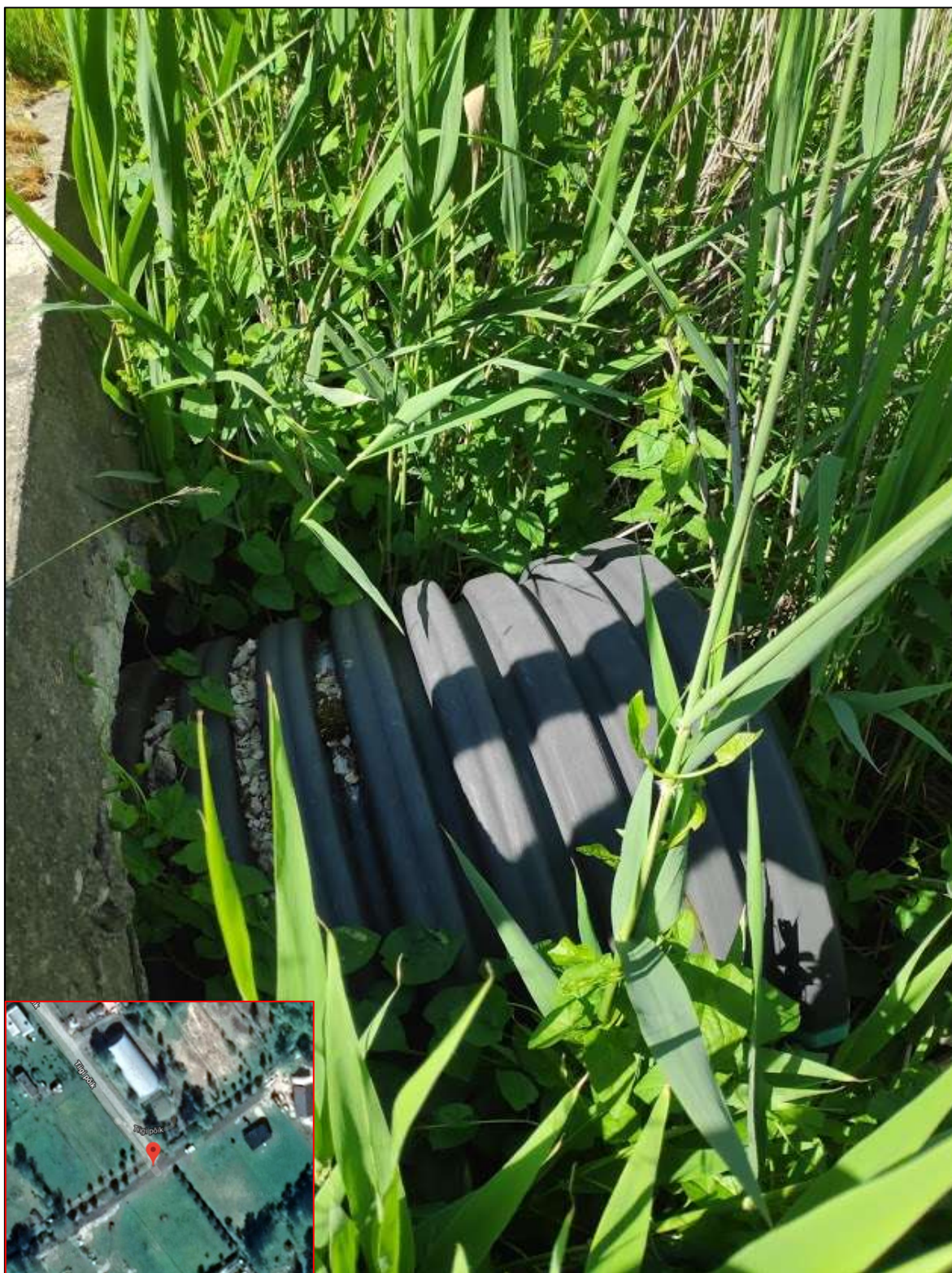
Pilt 17 Tõela peakraavi üks truupidest (Tiigi põik tänava alt; juuni, 2019)
