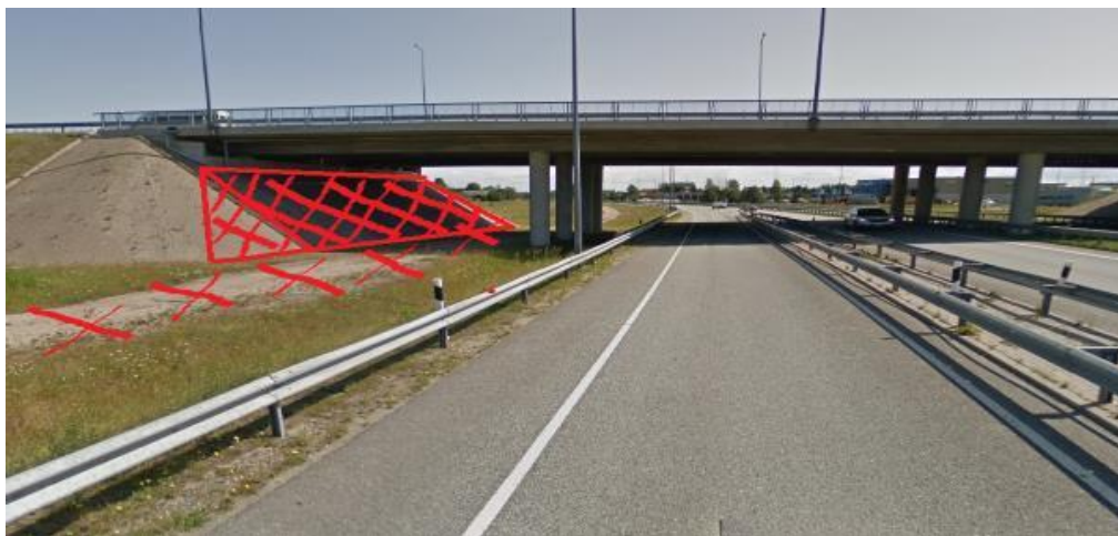
Joonis 4.3 Jõhvi 1. liiklussõlme viadukti aluse ruumi laiendamine koonuse eemaldamisel [2]
