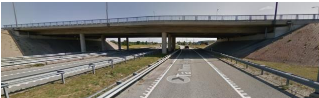
Joonis 1.8 Jõhvi 1.liiklussõlme viadukt [2]
